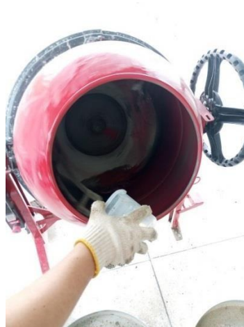
Figura 10 - Hidratação da betoneira
