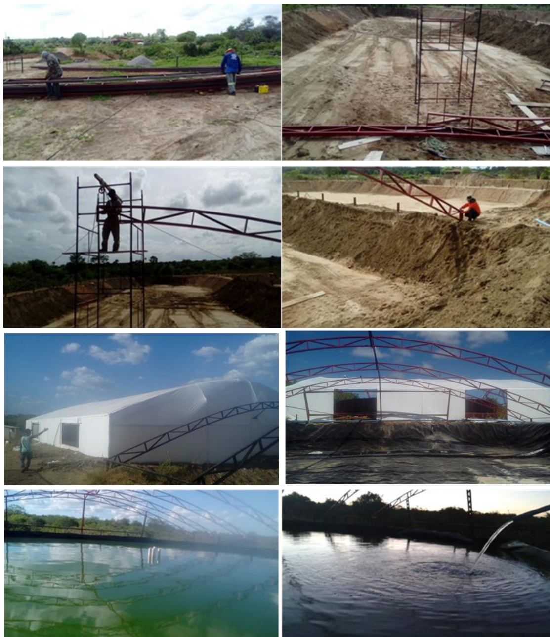
Figura 8: Construção, revestimento e cobertura das estufas e do berçário.
