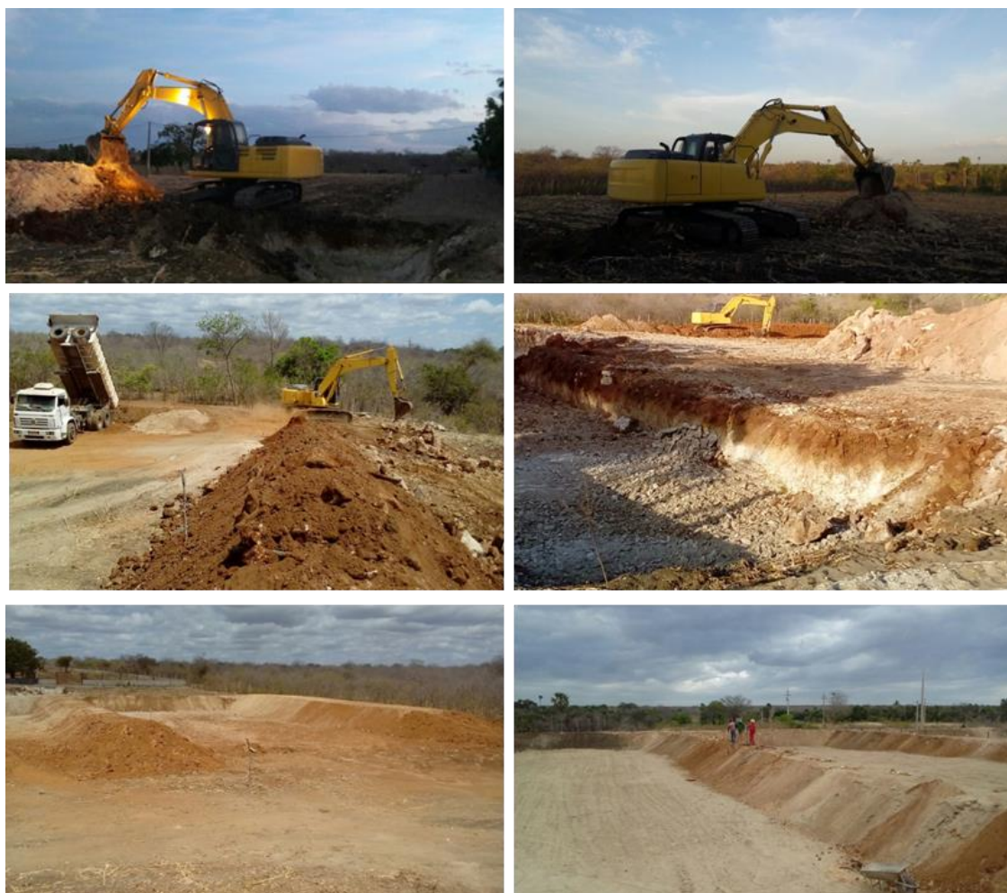
Figura 7: Maquinário escavadeira e caçamba, na construção dos viveiros da fazenda Pedregulho.
