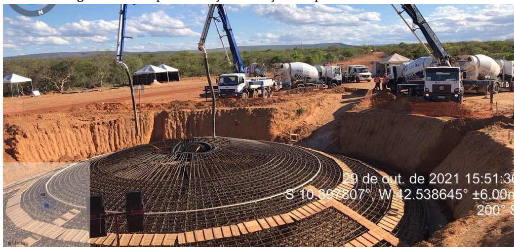
Figura 07: 1ª etapa de armação: fundação do tipo convencional elevada
