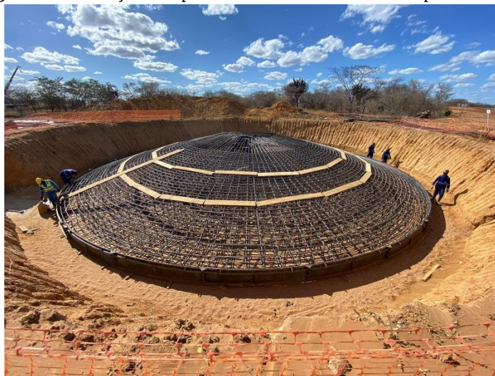
Figura 10: Fundação do tipo convencional elevada 1ª Etapa – Armação
