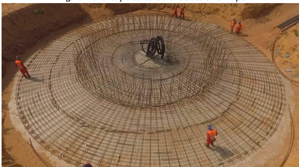
Figura 14: Fundação convencional elevada em armação
