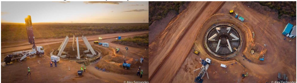
Figura 09: Fundação do tipo elevada: Jabalcone em Serra do mel/RN
