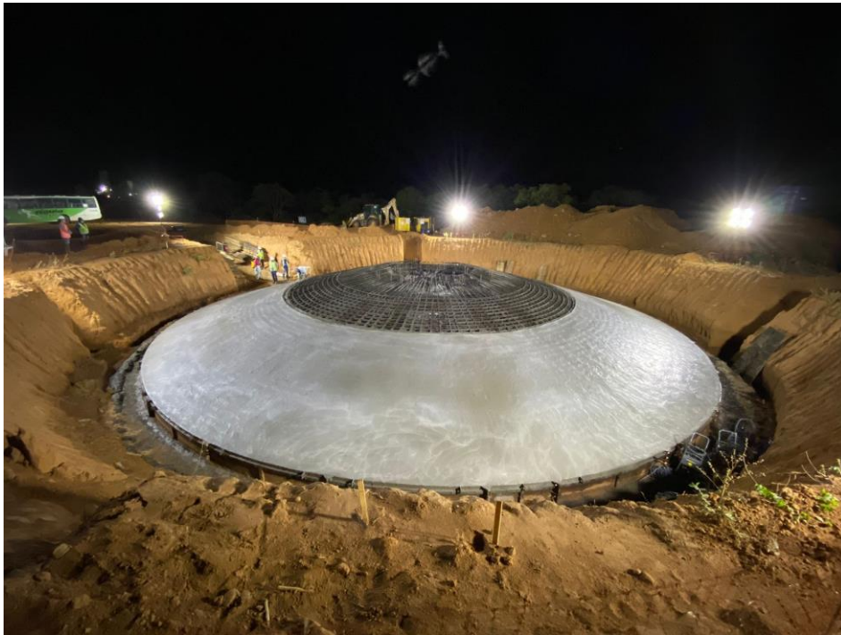
Figura 11: Concretagem de fundação do tipo convencional elevada
