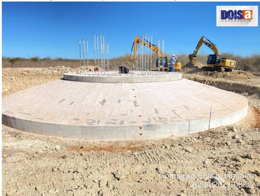
Figura 08: Fundação convencional – Reparo de fissura
