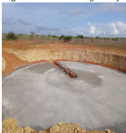
Figura 06: Concreto de regularização
