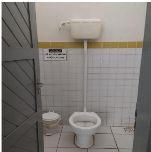
Figura 35 – Banheiro dos funcionários
