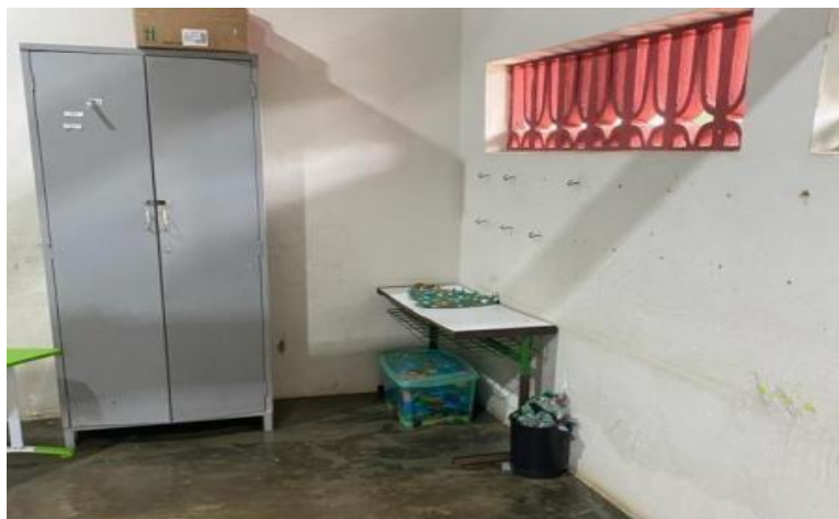
Figura 14 – Lixeira dispostas nas salas da Escola D
