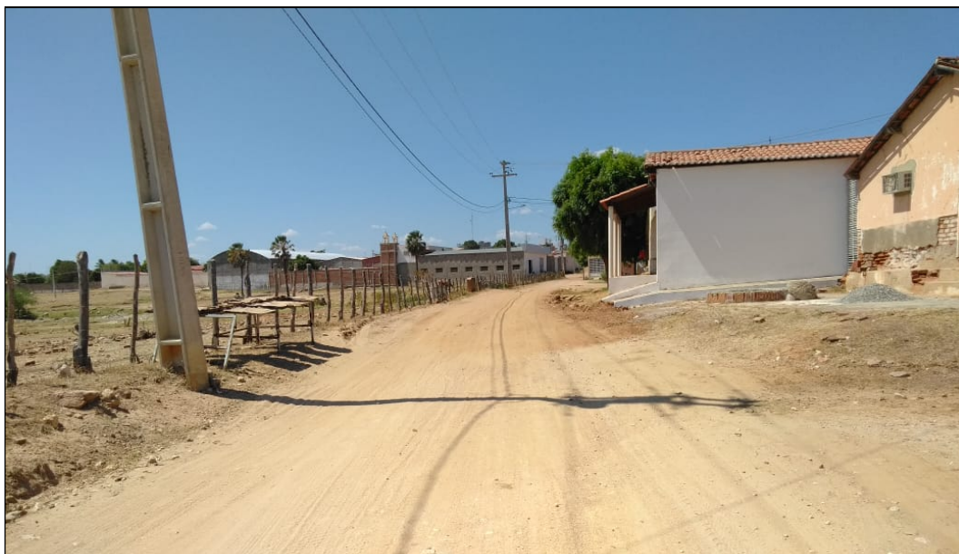
Figura 08: Novas edificações nas proximidades do Riacho.
