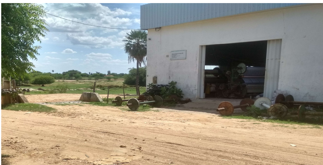
Figura 9: Fábrica Têxtil existente no local.
