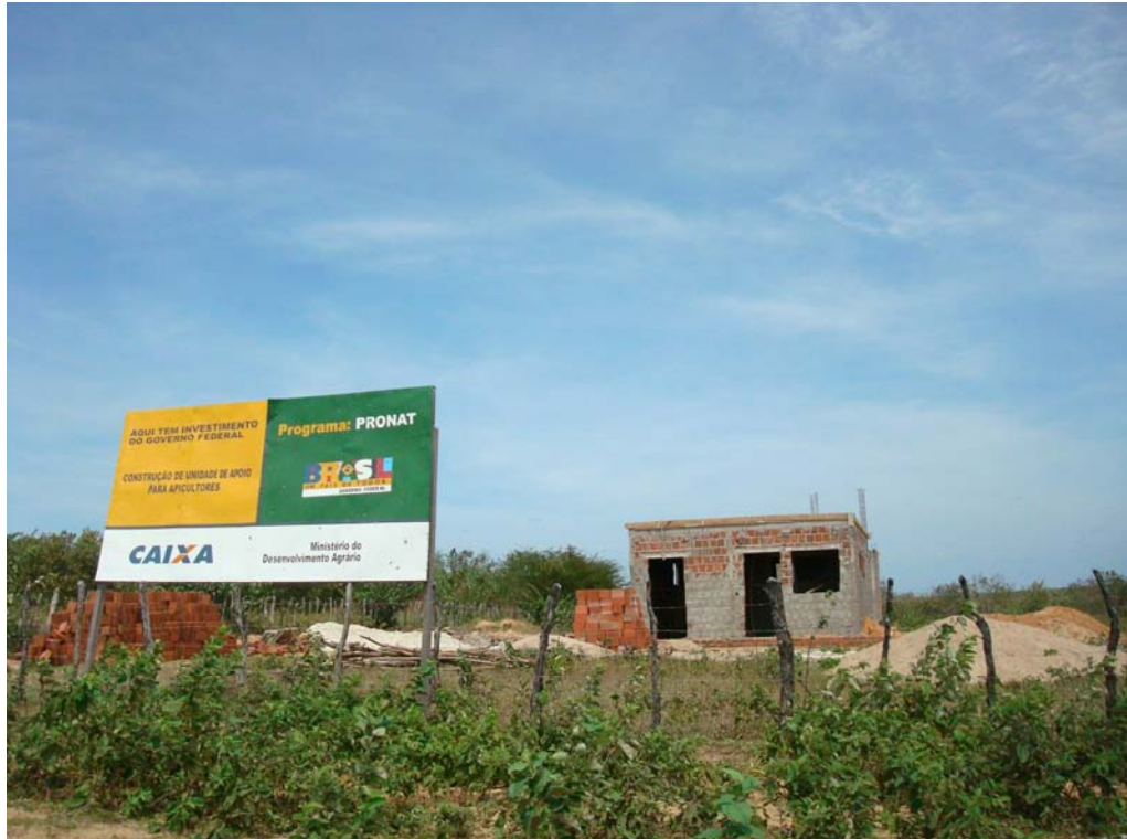
Figura 04 – Casa de mel sendo construída com recursos públicos em 2009 no P. A. Mulunguzinho em Mossoró-RN. (Foto do autor).
