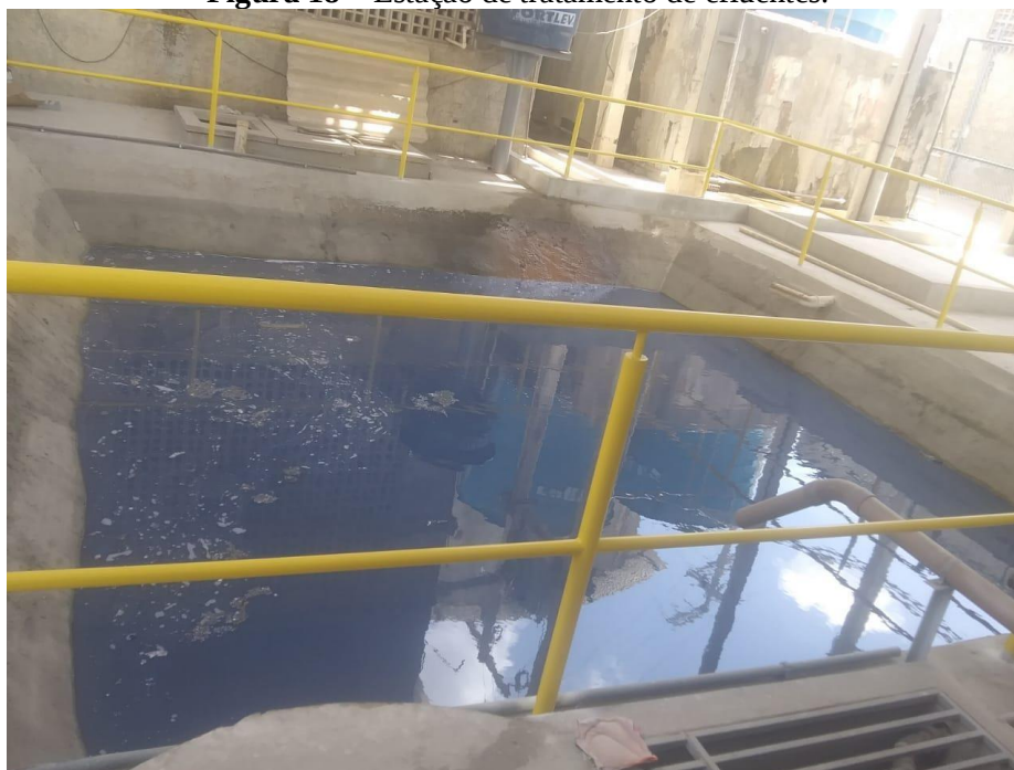
Figura 18 – Estação de tratamento de efluentes.
