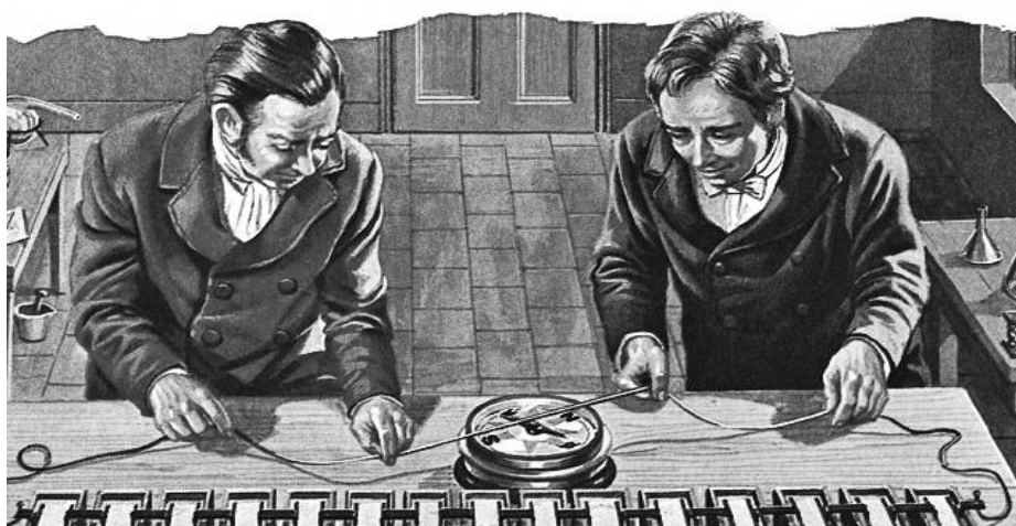
Figura 04: ilustração da experiência realizada por Oersted. Fonte: www.imamagnets.com/pt-pt/ . Acesso em agosto de 2021.
