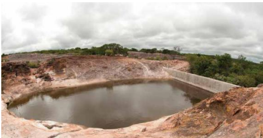
Figura 06: Barreiro construído em tanque de pedra.
