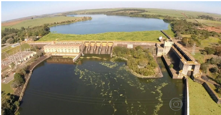
Figura 28: Acumulação de macrófitas aquáticas em hidrelétrica de Barra Bonita.
