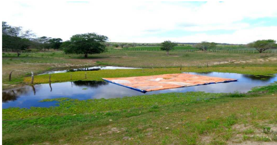
Figura 16: Redutor de evaporação sobre o açude.
