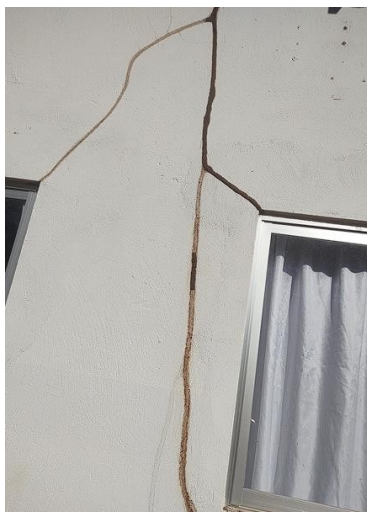
Figura 7: Ataque de cupins
