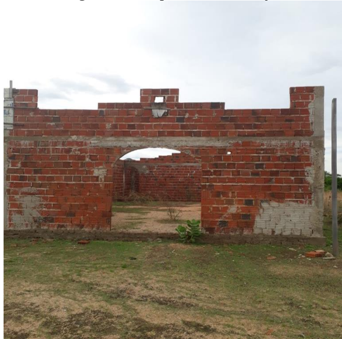
Figura 10 - Capela em construção
