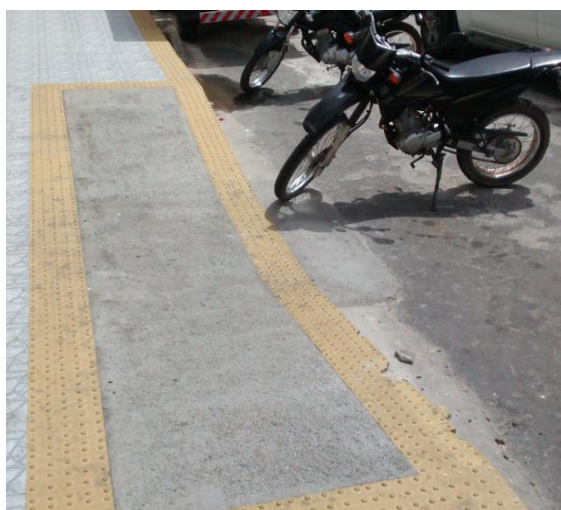
Figura 30: Bloqueio de rapas de acessibilidade por veículos – Centro de Pau dos Ferros-RN. Fonte: Acervo pessoal do autor, 2014.
