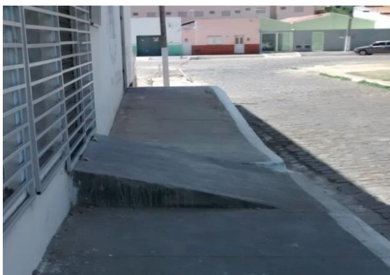
Figura 1: Rampas no passeio - Centro de Pau dos Ferros-RN.
