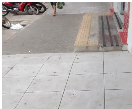
Figura 6: Incompatibilidade e falta de acessibilidade de pedestres - Centro de Pau dos Ferros-RN.
