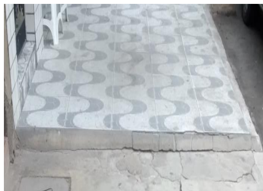
Figura 2: Rampas no passeio - Centro de Pau dos Ferros-RN.
