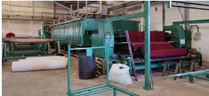
Figura 06 – Processo de secagem e engomagem dos tecidos.
