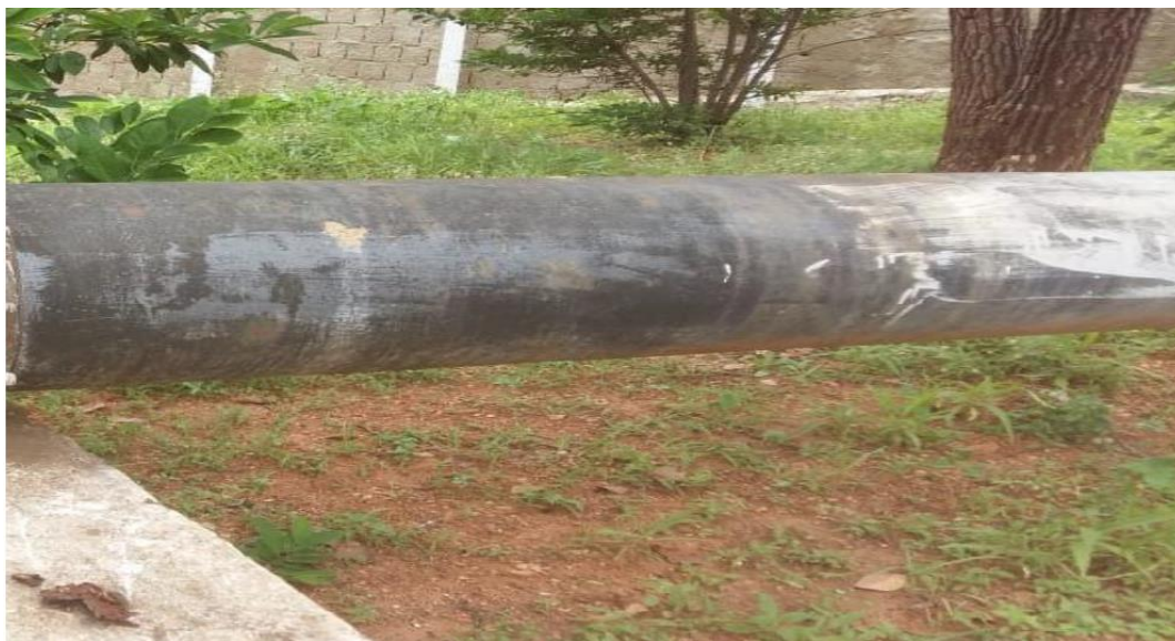
Figura 27: Tubulações de ferro fundido a ser comparada.
