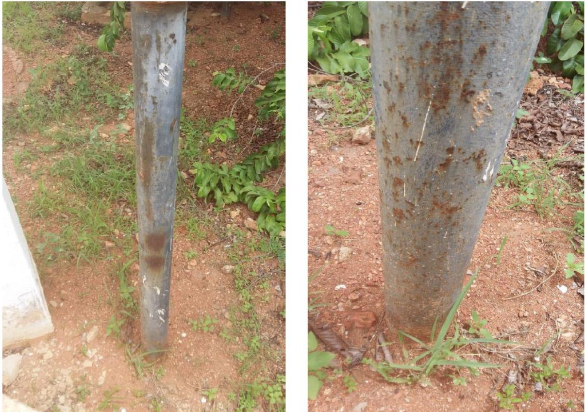
Figura 26: Tubulações de ferro fundido a ser comparada.
