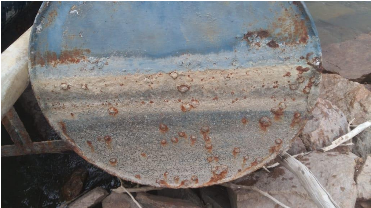
Figura 35: Lateral da boia deteriorada em 2019.
