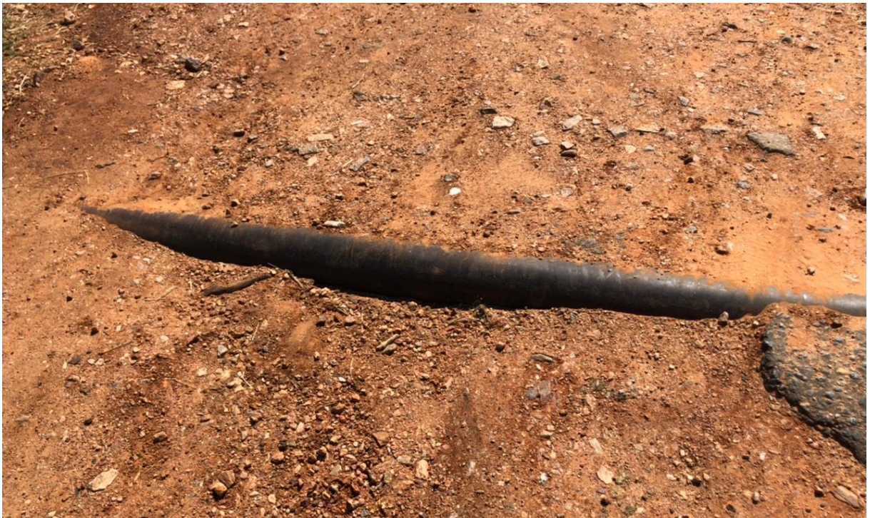
Figura 24: Tubulação de ferro fundido semi-enterrada.
