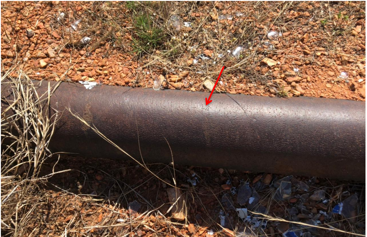
Figura 25: Tubulação de ferro fundido semi-enterrada.
