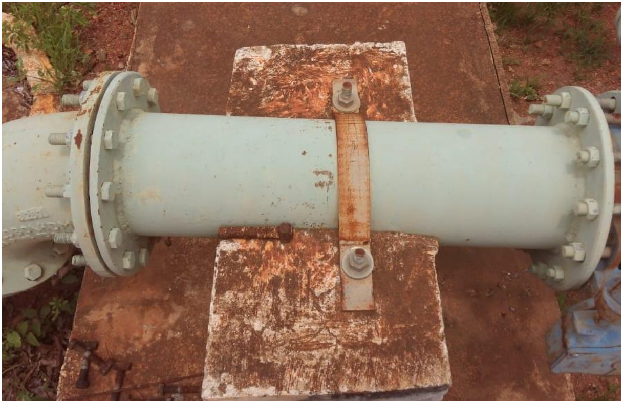
Figura 31: Braçadeira de fixação em material metálico.
