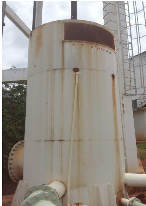
Figura 39: Reservatório em processo corrosivo em 2019.
