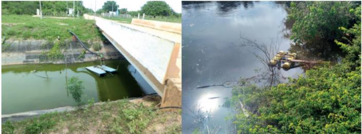
Figura 2: Captação do tipo superficial flutuante.
