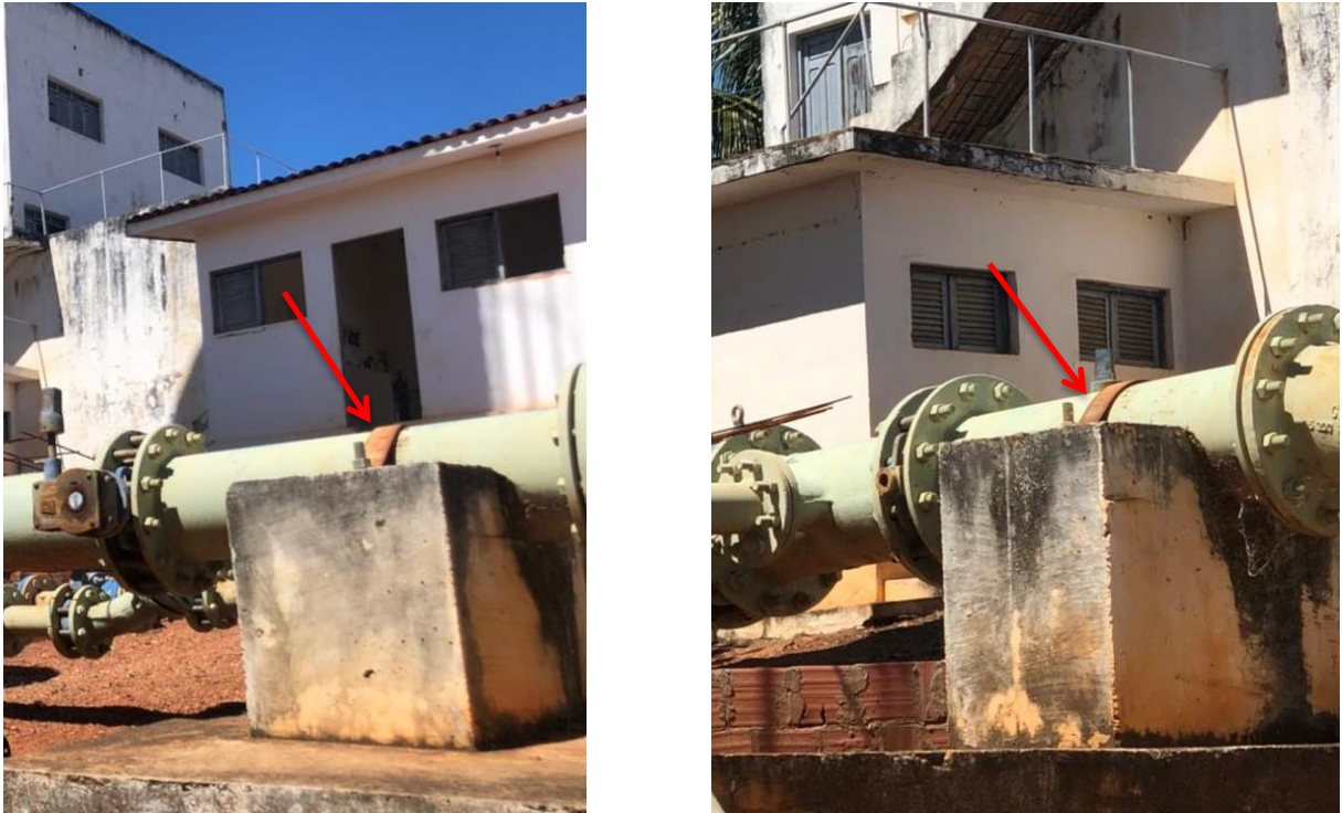
Figura 30: Braçadeira metálica.
