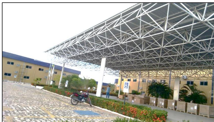
Figura 8: Cobertura da área externa do IFRN-Pau dos Ferros. Fonte: Autora.
