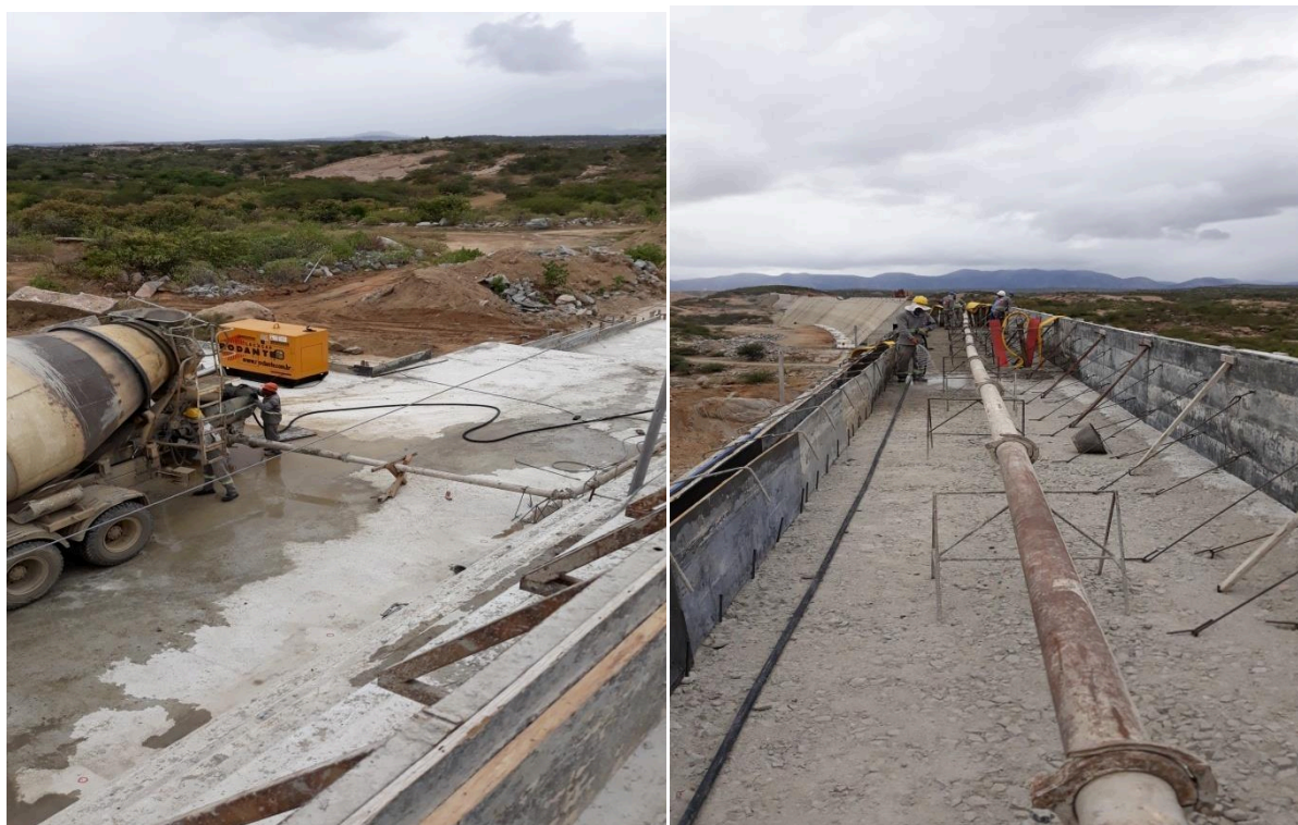
Figura 10: Detalhe da concretagem da parede da barragem.
