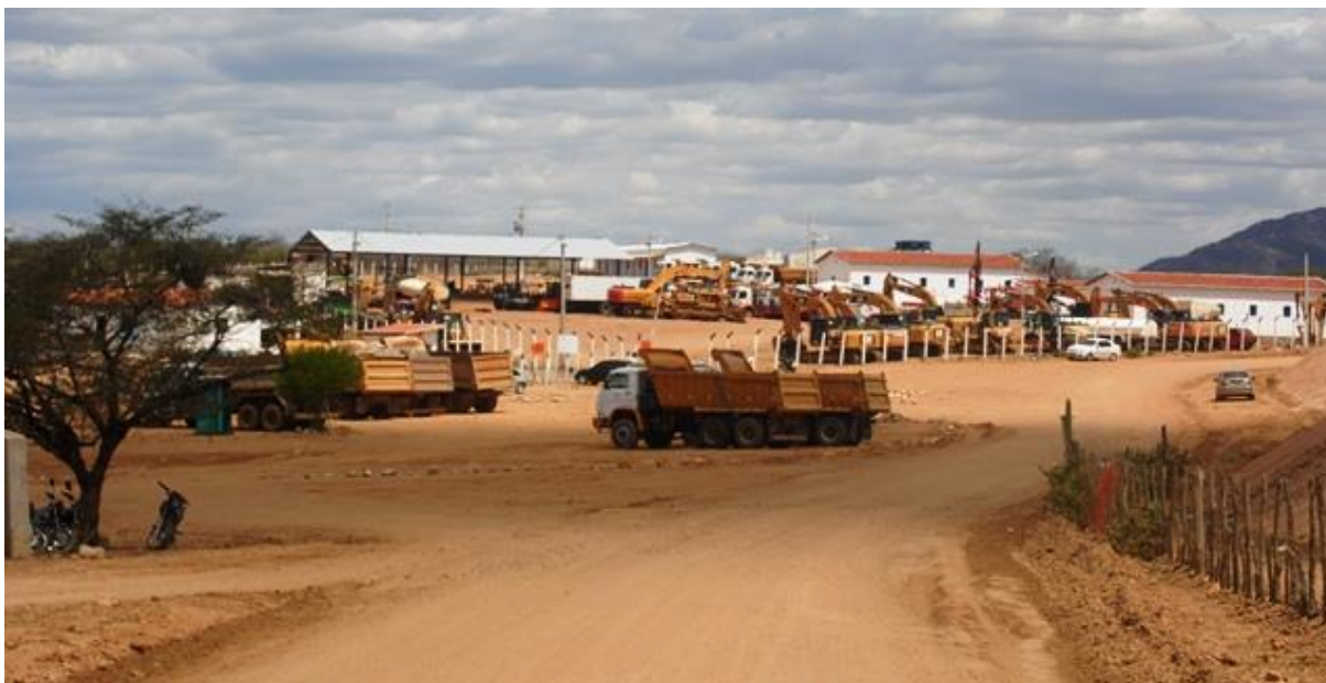
Figura 4: Canteiro de obras da Barragem da Oiticica
