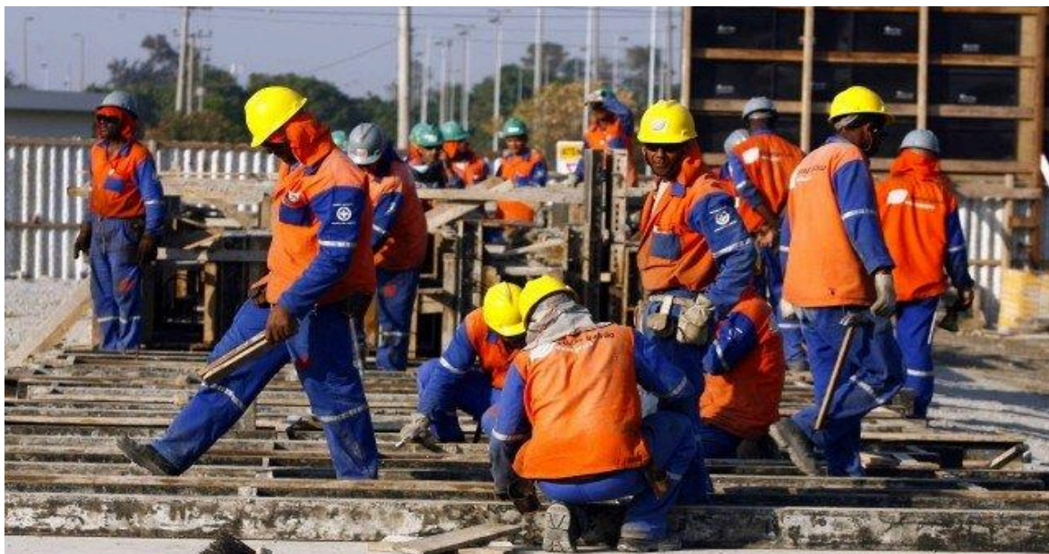
Figura 2: Trabalhadores usando EPI's
