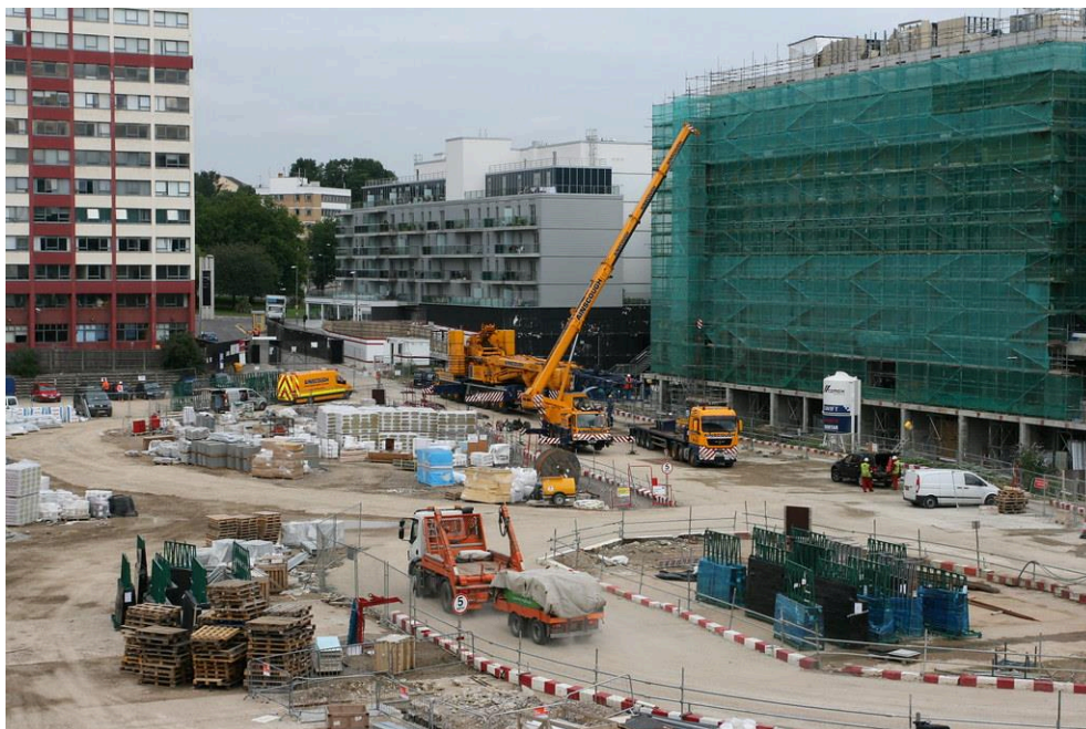
Figura 1: Canteiro de obras organizado
