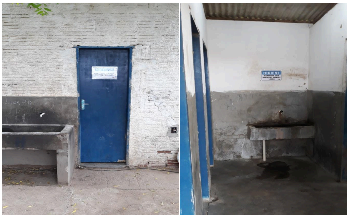
Figura 5: Detalhe das instalações sanitárias
