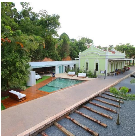
Figura 6 - Vista da pousada Estação Bananeiras.
