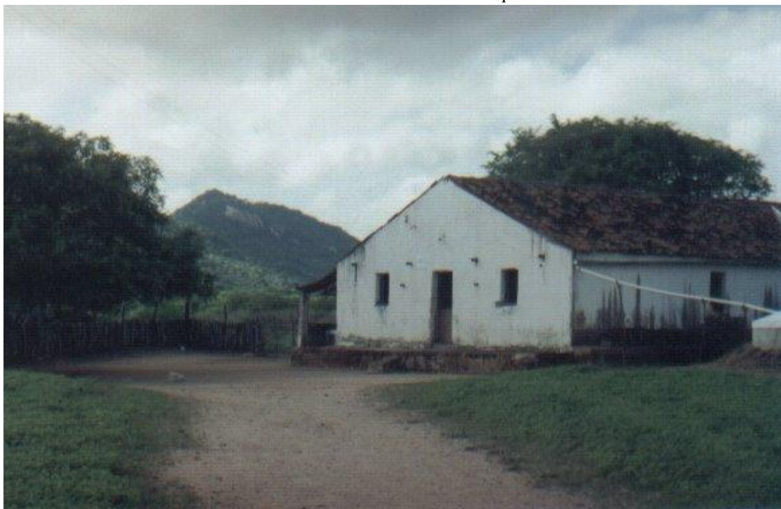
Foto 2: Primeira casa construída na comunidade quilombola Jatobá
