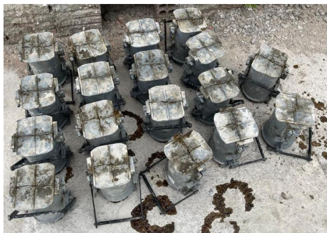
Figura 9: Aplicação do desmoldante
