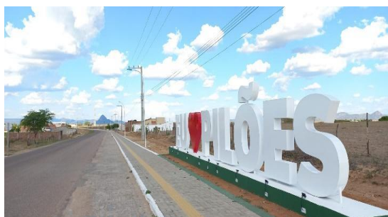
Figura 30: Pavimentação da Entrada do Município
