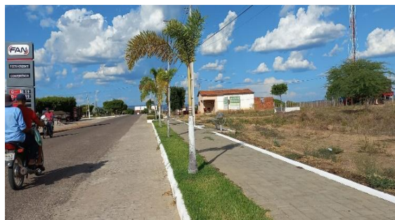
Figura 31: Pavimentação da Entrada Do Município
