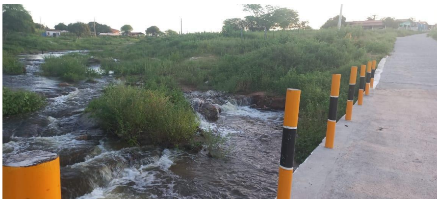
Figura 20: Sangradouro do Açude Público de Pilões – RN, data 04/maio/2023
