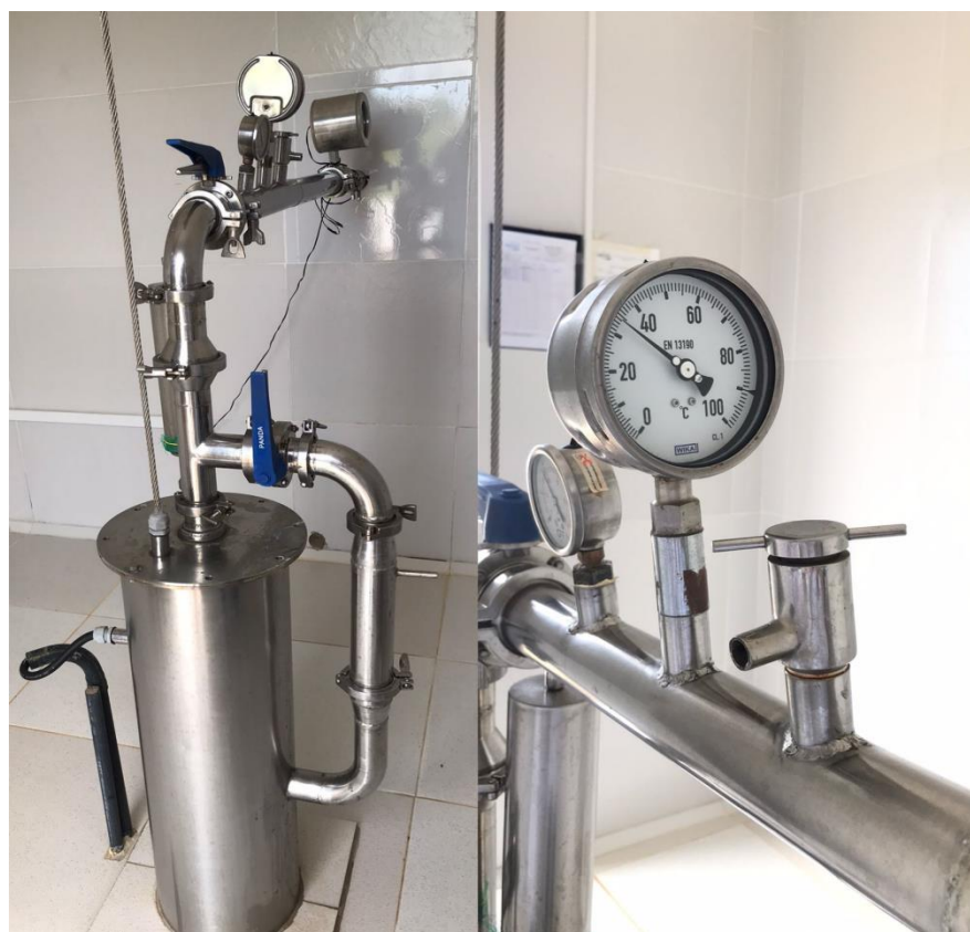
Figura 3: Casa de proteção do poço de envase.
