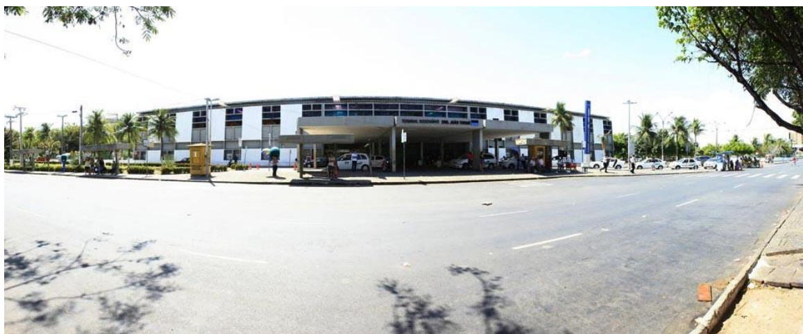
Figura 31 : Fachada frontal, terminal de Fortaleza
