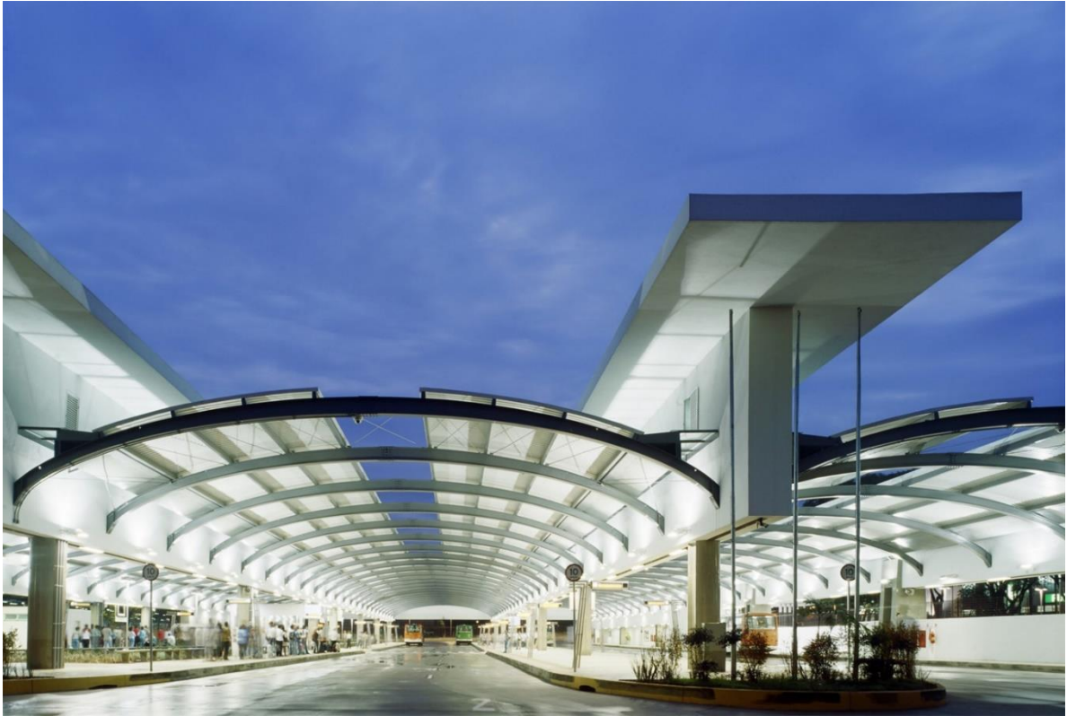
Figura 46 : Fachada posterior do terminal da Lapa
