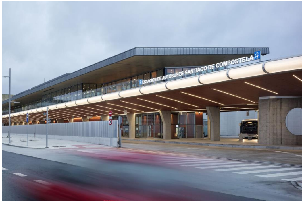
Figura 36 : Fachada do terminal de Santiago de Compostela
