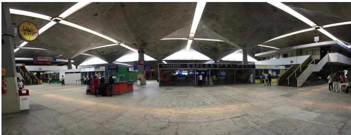
Figura 34 : Pavimento térreo, vista interna
