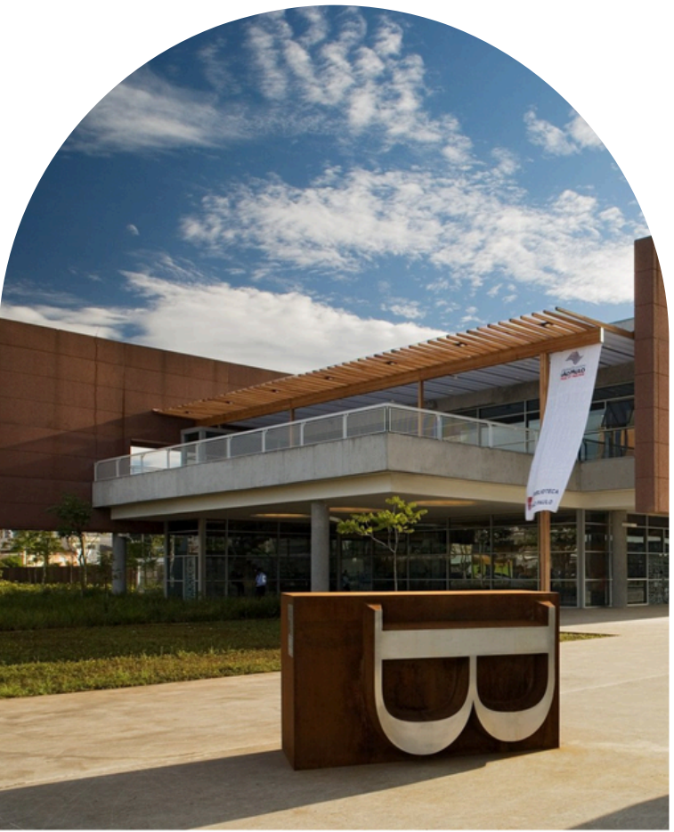
Biblioteca São Paulo Arquiteto: aflalo/gasperini arquitetos Localização: São Paulo, SP Área: 4.527 m² Ano: 2010 A Biblioteca de São Paulo forneceu referências relacionadas ao conforto ambiental e à organização espacial. O emprego de brises para proteção solar, o aproveitamento da ventilação natural e a distribuição funcional dos ambientes orientaram decisões projetuais adotadas na Biblioteca Parque Entrelinhas.
