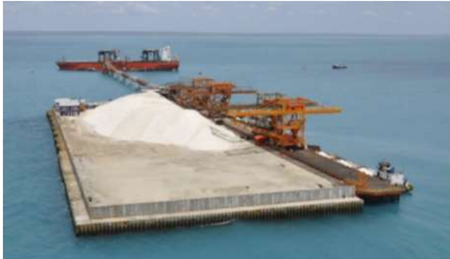
Figura 2 - Terminal Salineiro de Areia Branca (TERSAB)
