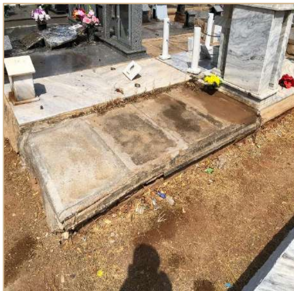
Figura 49 - Túmulo com Fissuras Laterais na Tampa no Cemitério Parque da Saudade
