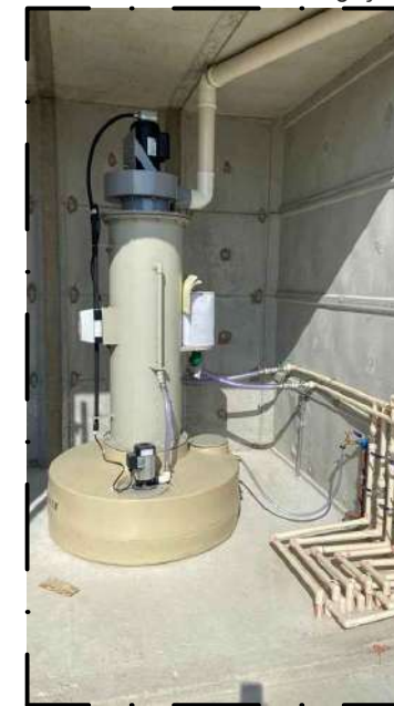
13 Exemplo de um inativador de gases Sem Escala
