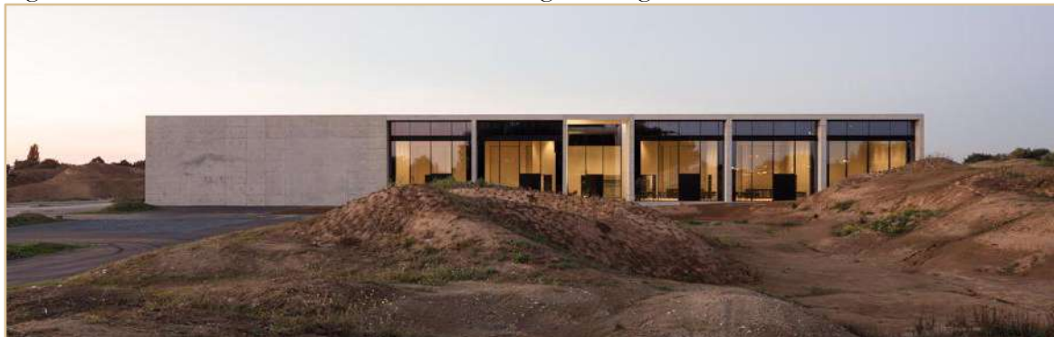
Figura 18 - Fachada Frontal do Crematório Siesegem, Bélgica
