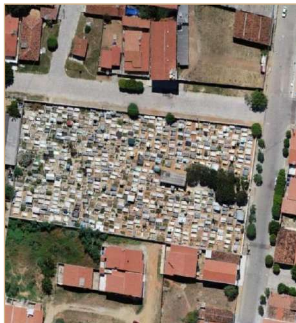
Figura 42 - Aerofotografia do Cemitério São Manoel
