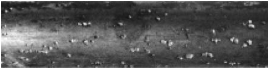
Figura 8: Corrosão por pite em tubo de aço inoxidável
