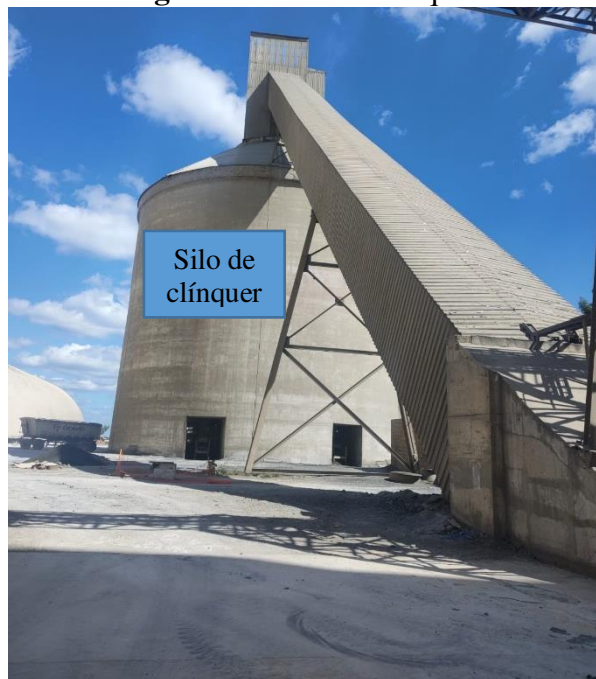
Figura 21: Silo de clínquer.
