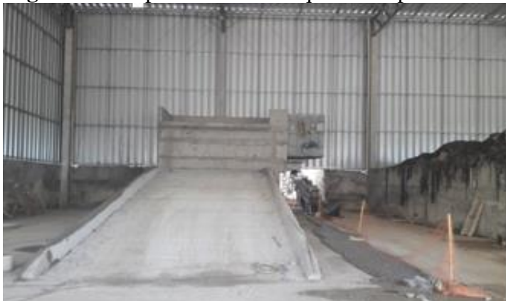
Figura 27: Galpão de materiais que são coprocessados.
