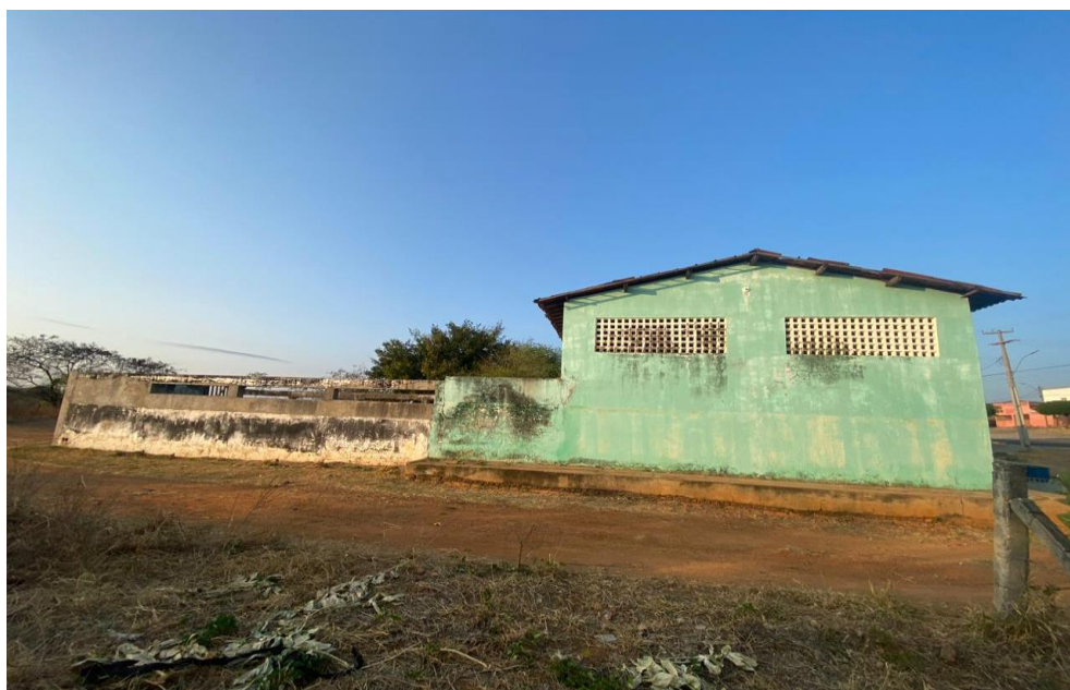
Figura 06 – Vista lateral do abatedouro público de José da Penha – RN.
