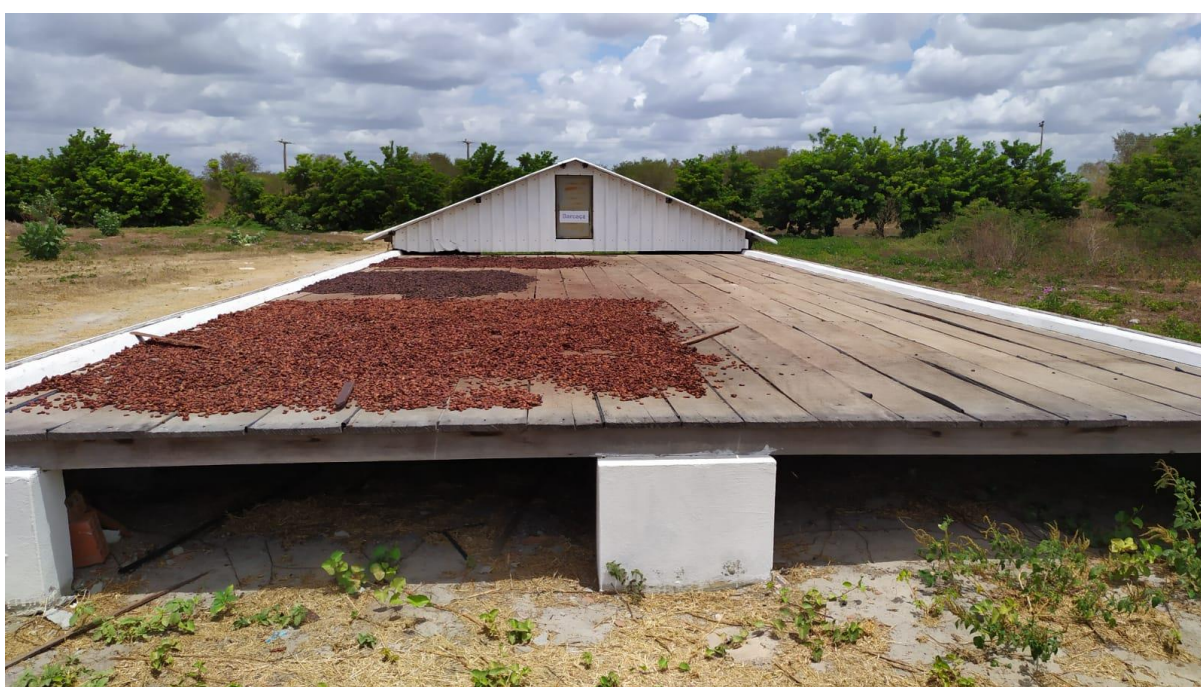
Figura 12: Barcaça para a secagem das amêndoas de cacau, na fazenda Frutacor, localizada no Tabuleiro de Russas, entre as cidades de Limoeiro do Norte-CE e Russas-CE. Fonte: Genilson Araújo, 2021.
