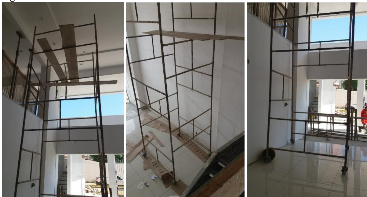
Figura 26 - Trabalho em andaimes
