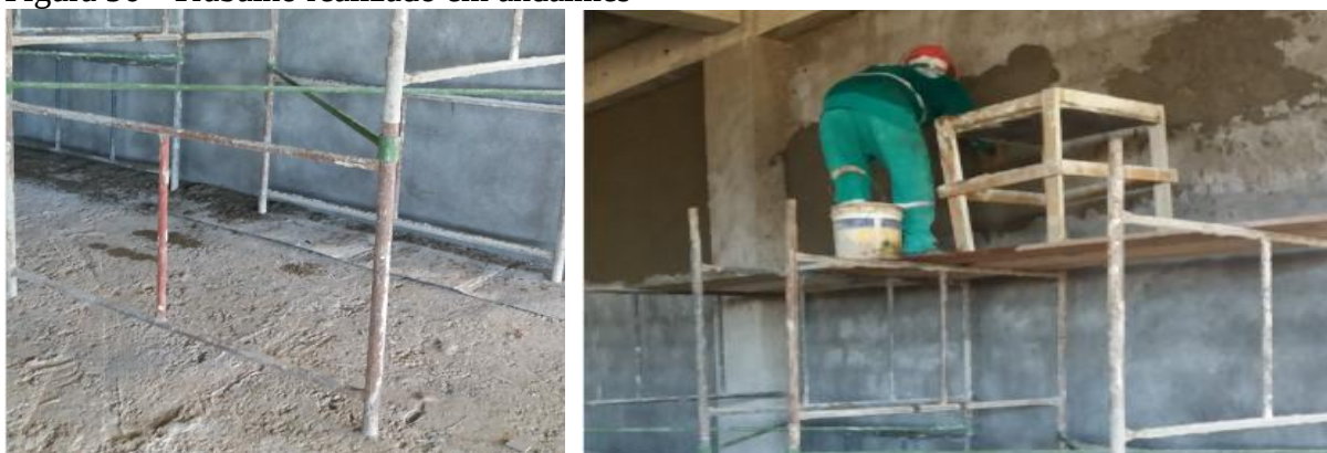
Figura 56 - Trabalho realizado em andaimes
