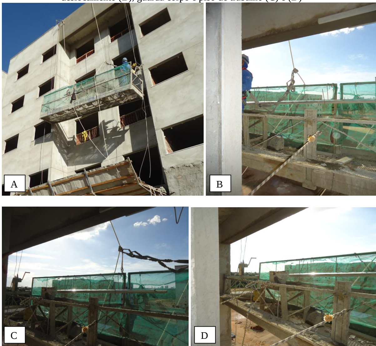
Figura 42 - Andaime suspenso (A), andaimes travado de forma a não permitir seu deslocamento (B), guarda corpo e piso de trabalho (C) e (D)
