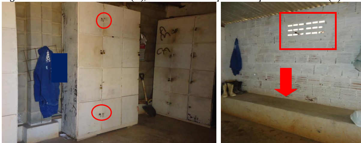
Figura 35 - Armários individuais (A), Bancos e iluminação/ventilação dos vestiários (B)
