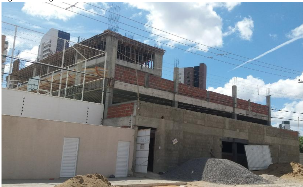
Figura 2 - Estágio da obra 1 no dia da visita
