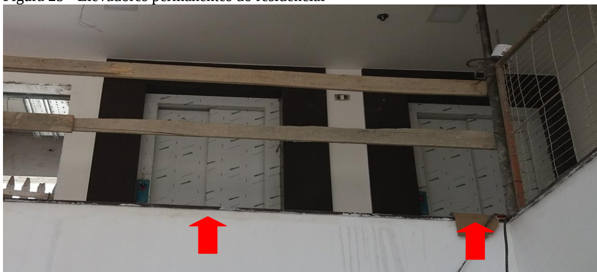
Figura 25 - Elevadores permanentes do residencial
