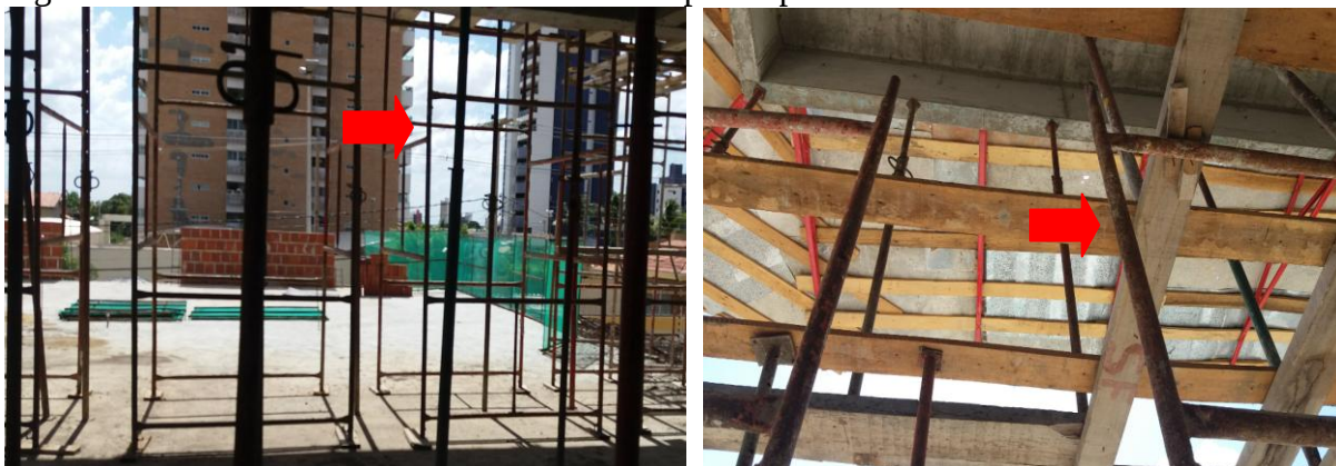
Figura 11 - Andaimes sendo utilizados como suportes para escoras
