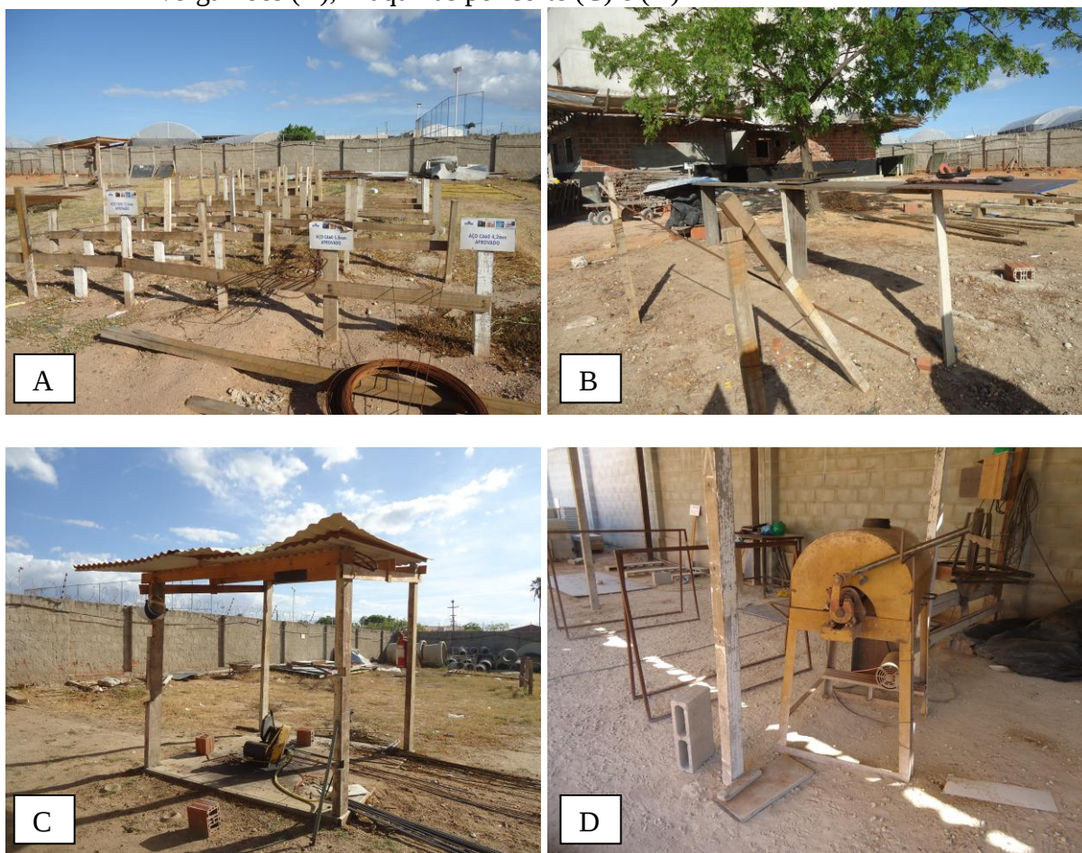
Figura 39 - Armazenagem e estoque de ferragens (A), bancada para dobragem e corte de vergalhões (B), Máquinas policorte (C) e (D)
