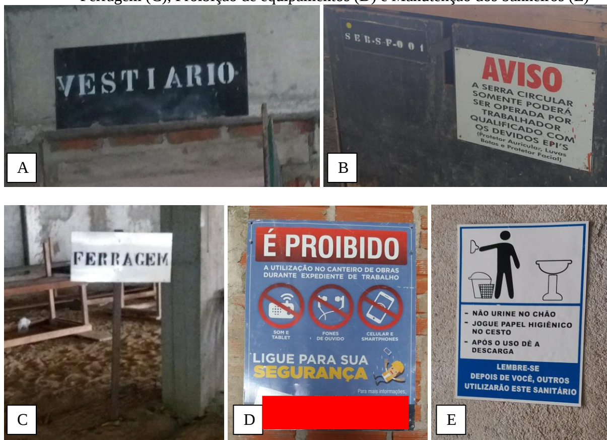
Figura 14 - Placas de sinalização: Vestiário (A), Indicação do fabricante e uso de EPI's (B), Ferragem (C), Proibição de equipamentos (D) e Manutenção dos banheiros (E)
