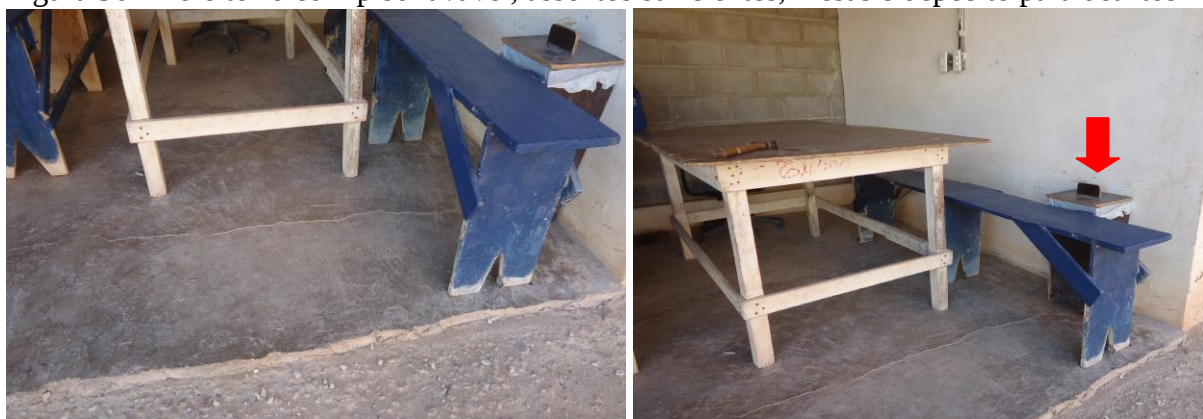
Figura 36 - Refeitório com piso lavável, assentos suficientes, mesas e depósito para detritos
