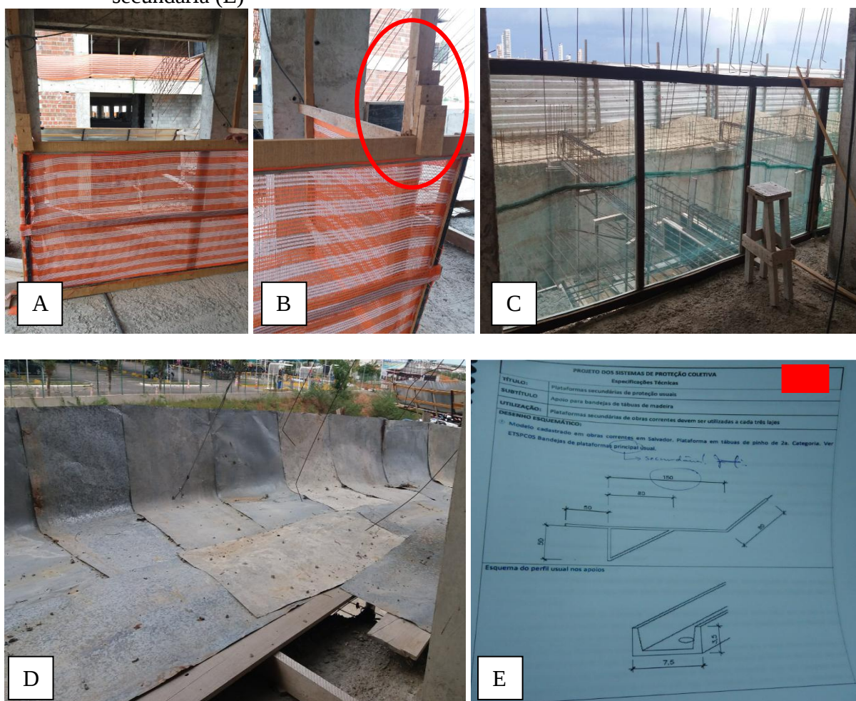
Figura 54 - Abertura para transporte vertical de materiais (A) com fechamento do tipo cancela (B), peitoris de proteção (C), plataforma principal (D) e projeto da plataforma secundária (E)
