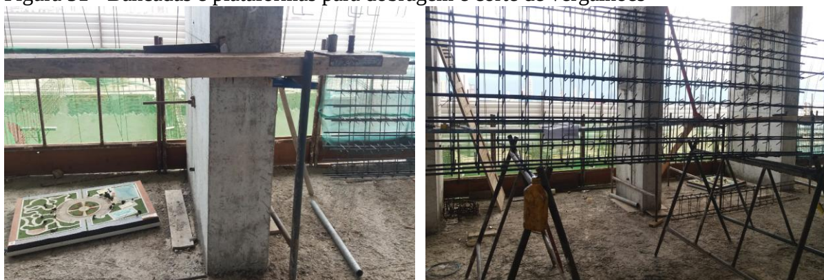
Figura 51 - Bancadas e plataformas para dobragem e corte de vergalhões
