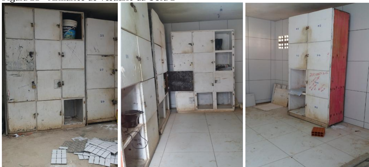
Figura 21 - Armários do vestiário da Obra 2
