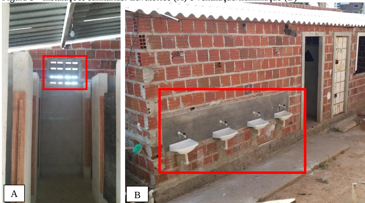
Figura 5 - Instalações sanitárias: Lavatórios (A) e ventilação/iluminação (B)
