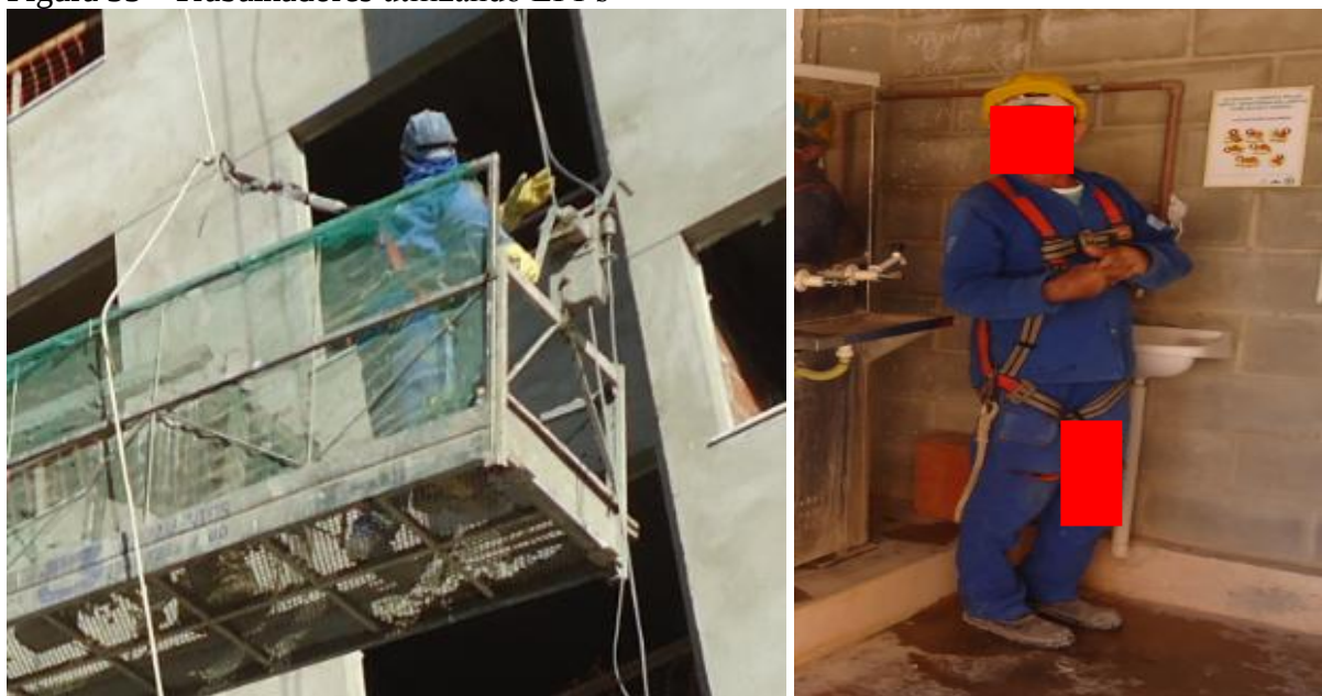
Figura 33 - Trabalhadores utilizando EPI's
