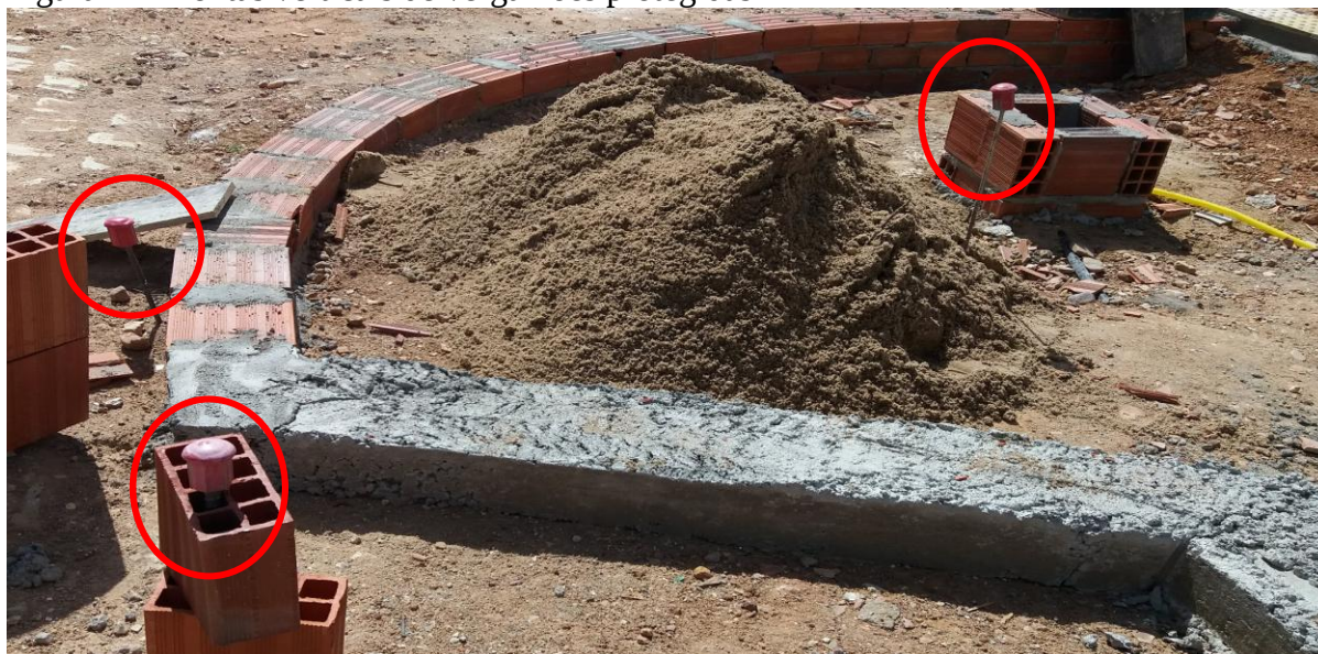
Figura 22 - Pontas verticais de vergalhões protegidas
