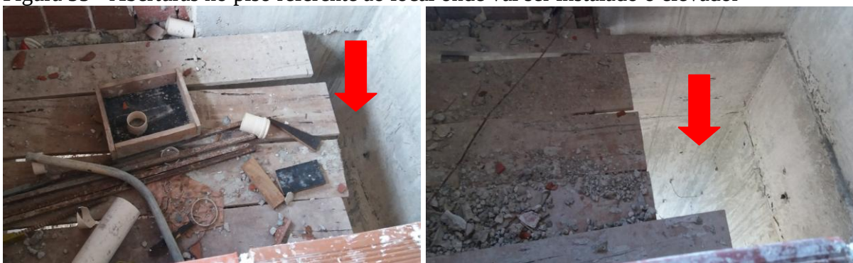
Figura 55 - Aberturas no piso referente ao local onde vai ser instalado o elevador
