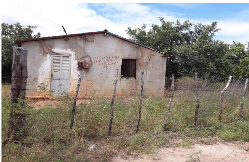
Figura 6 - Casa da comunidade que ainda possui estrutura original
