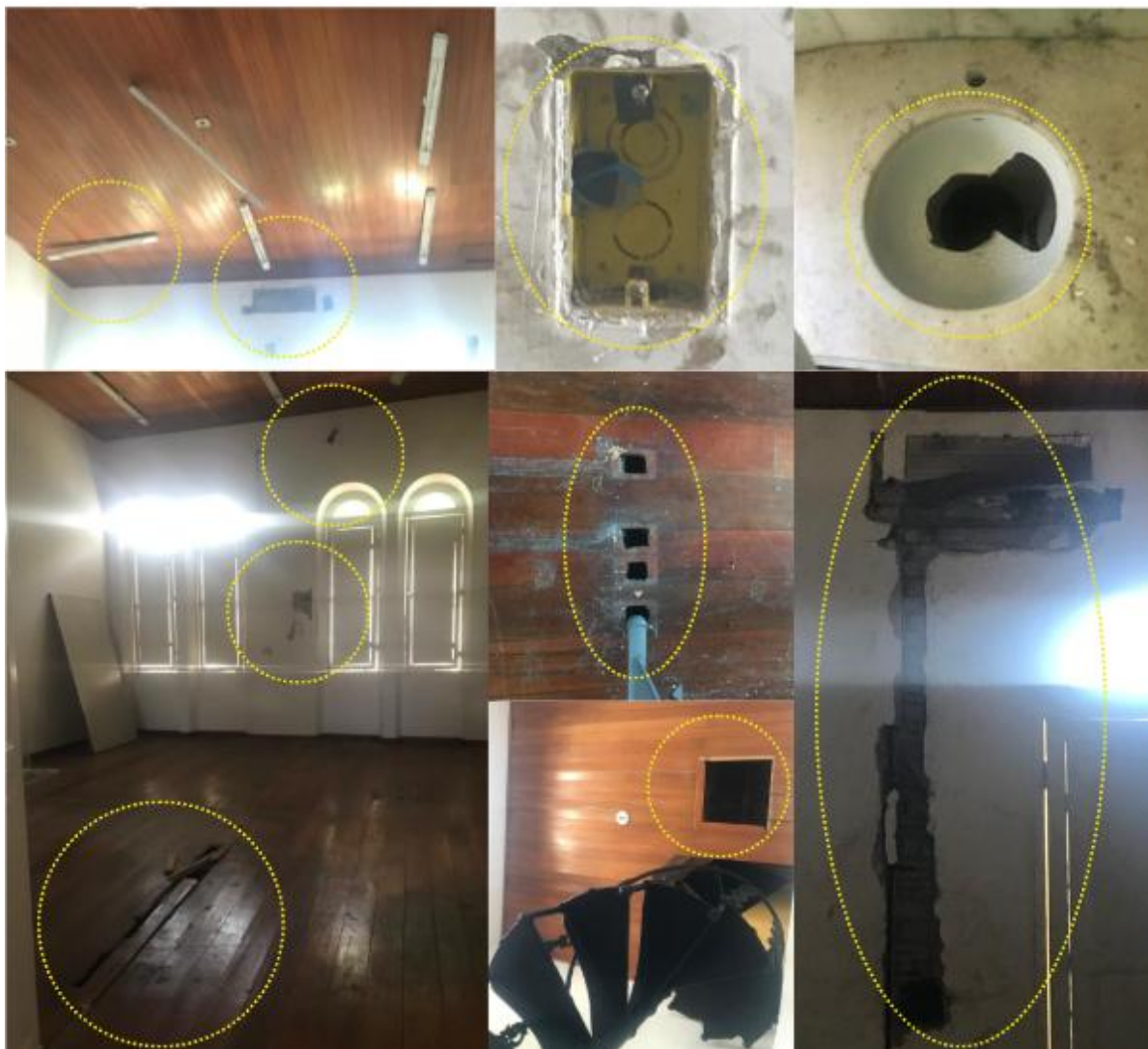
Figura 1 - Forro, iluminação, tomadas, cuba, alvenarias, esquadrias e pisos
