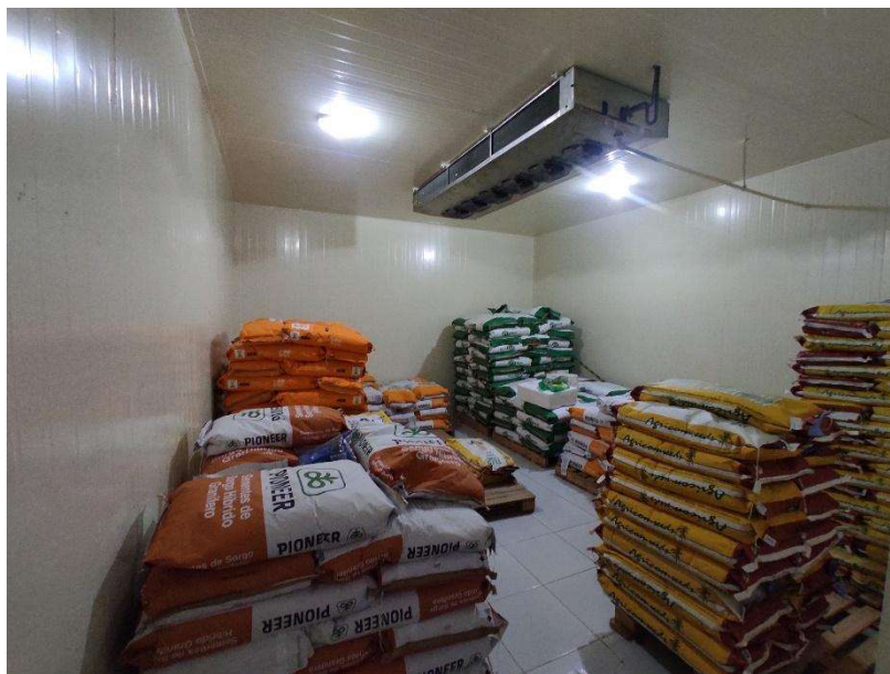
Figura 2: Câmara fria, Terra Fértil, Limoeiro do norte.
