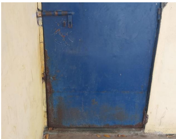
(a) Portão da entrada lateral direita – área externa.
