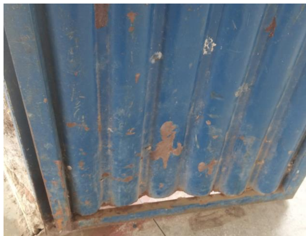
(c) Ampliação do portão de entrada para as arquibancadas.
