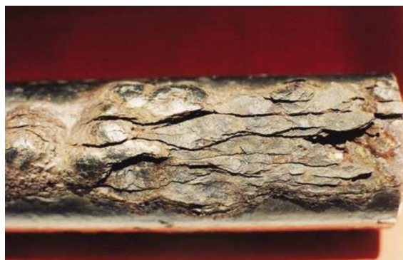
Figura 11: Corrosão por esfoliação em tubo de aço-carbono.
