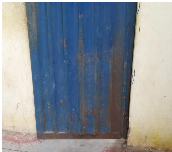
(d) Portão entrada lateral esquerda - área interna.
