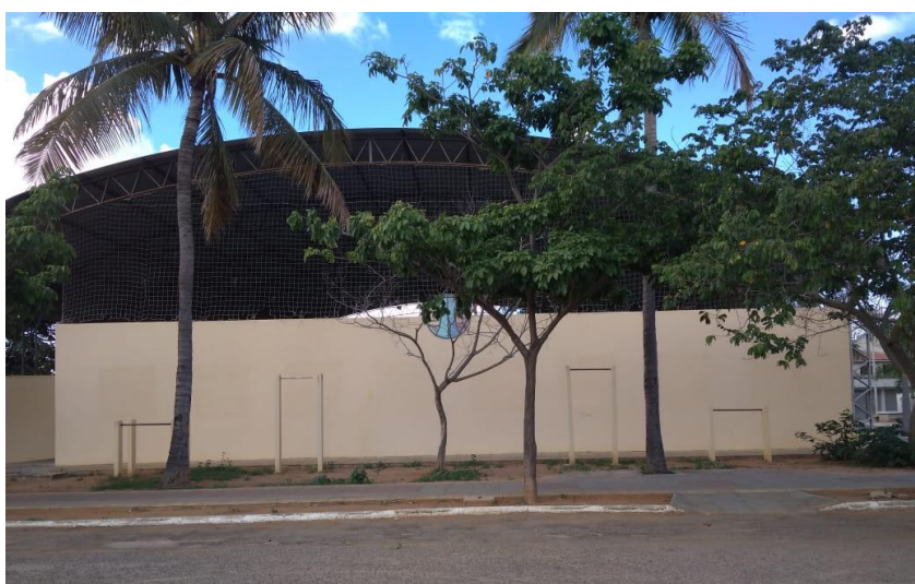
Figura 18: Vista frontal da quadra.
