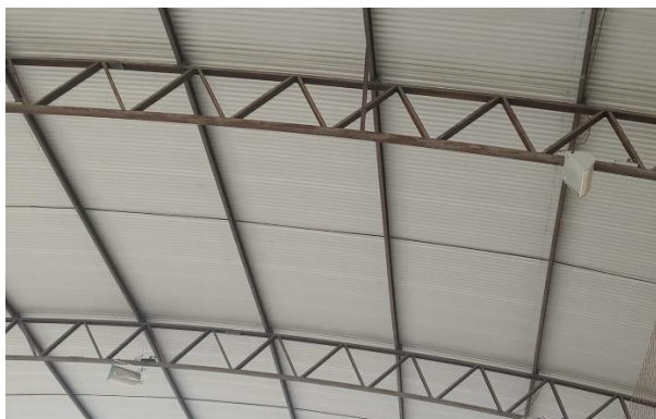
(b) Estrutura de suporte do teto.
