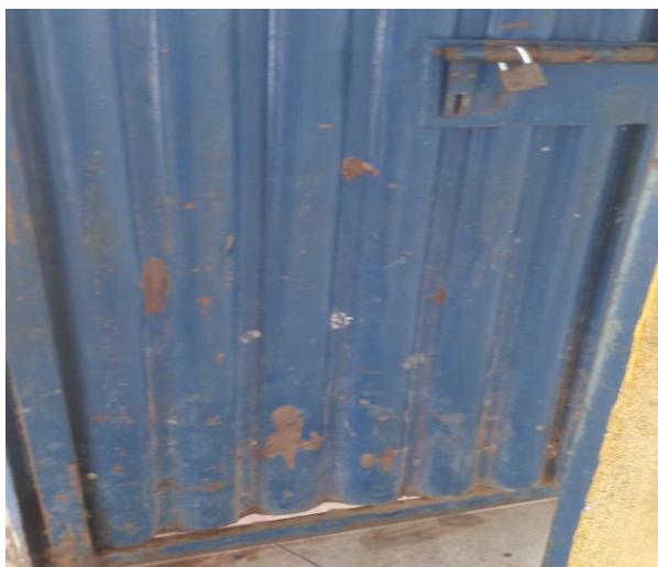
(b) Portão de entrada para as arquibancadas.
