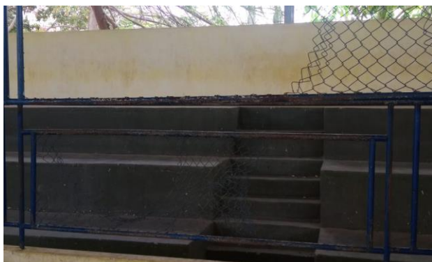
(a) Estrutura que separa a quadra da arquibancada.
