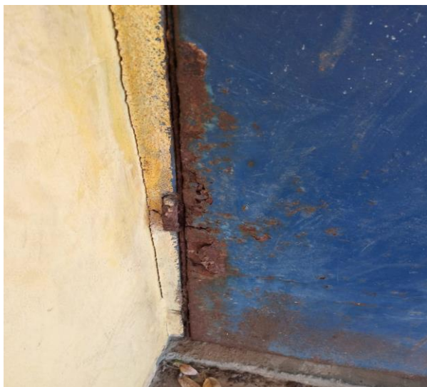
(b) Trave solta que se desprendeu do chão.
