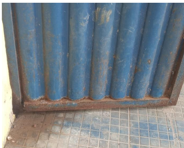
(c) Portão entrada lateral esquerda - área externa.
