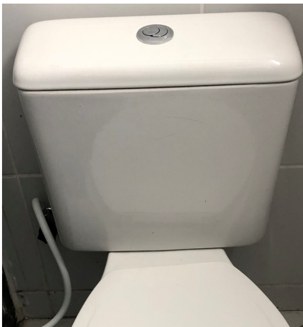
Figura 2: Bacia sanitária com descarga de duplo acionamento
