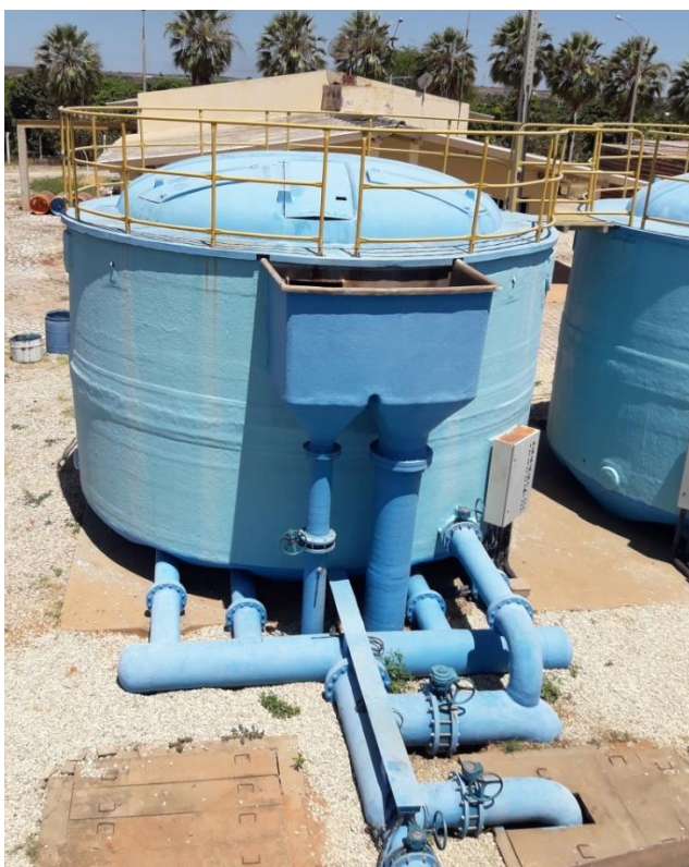
Figura 4 - Filtração ascendente (externa).
