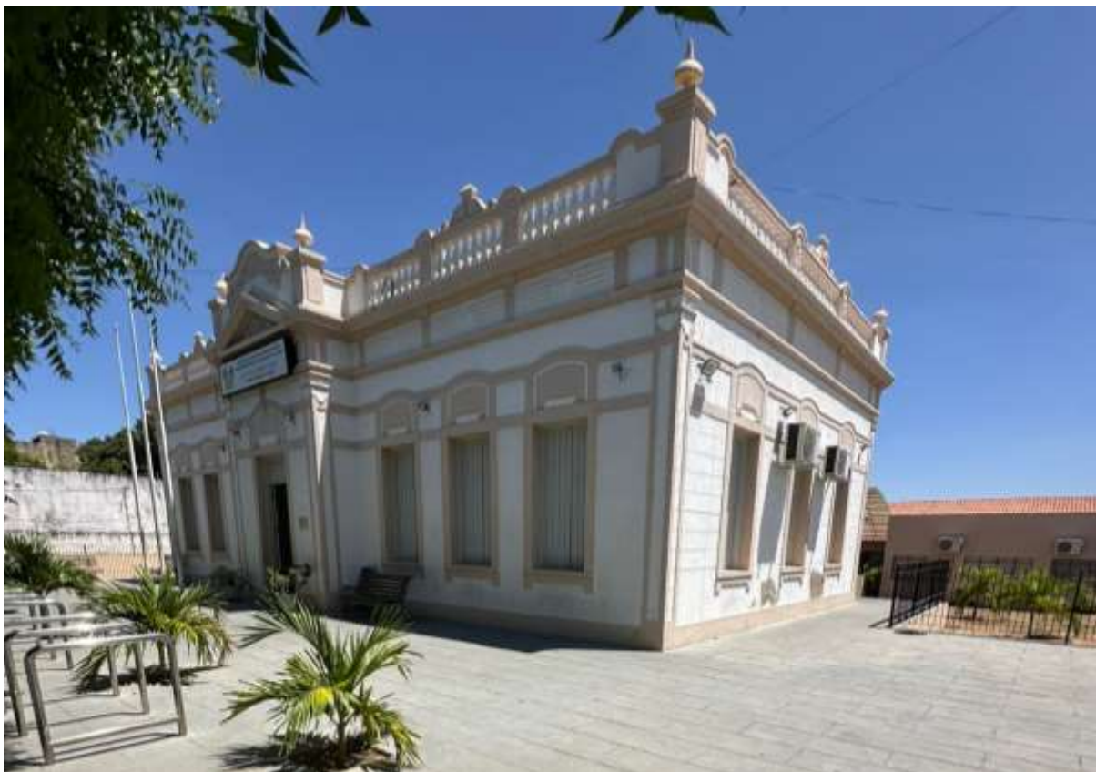
Figura 14- Foto Atual da fachada da Escola
