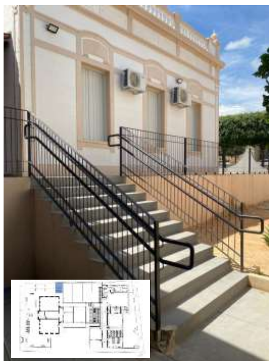
Figura 23 – Corrimão e Guarda Corpo
