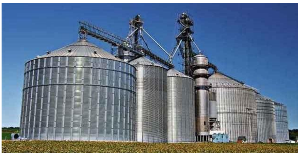
Figura 1 - Silo para armazenamento de grãos.
