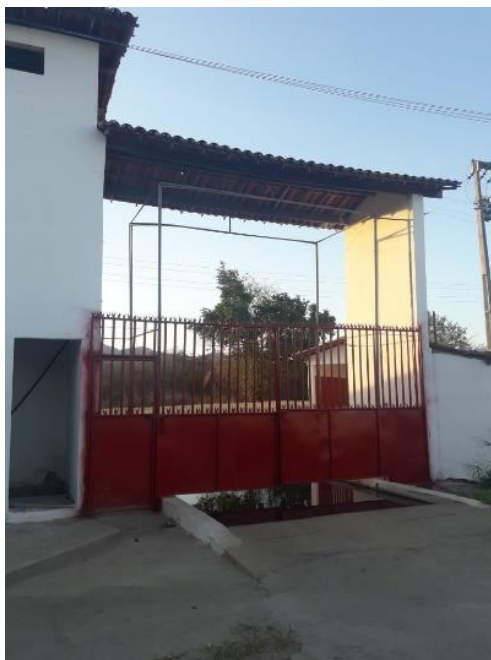
Figura 1-Entrada para lavagem e desinfecção de veículos
