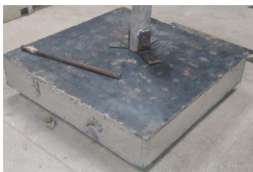
Figura 11. Base para a torre do aerogerador
