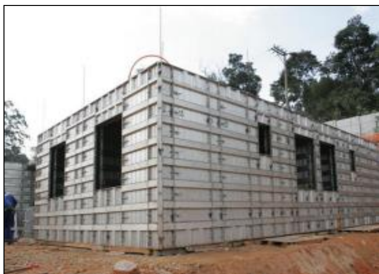
Figura 03: Fôrmas de alumínio
