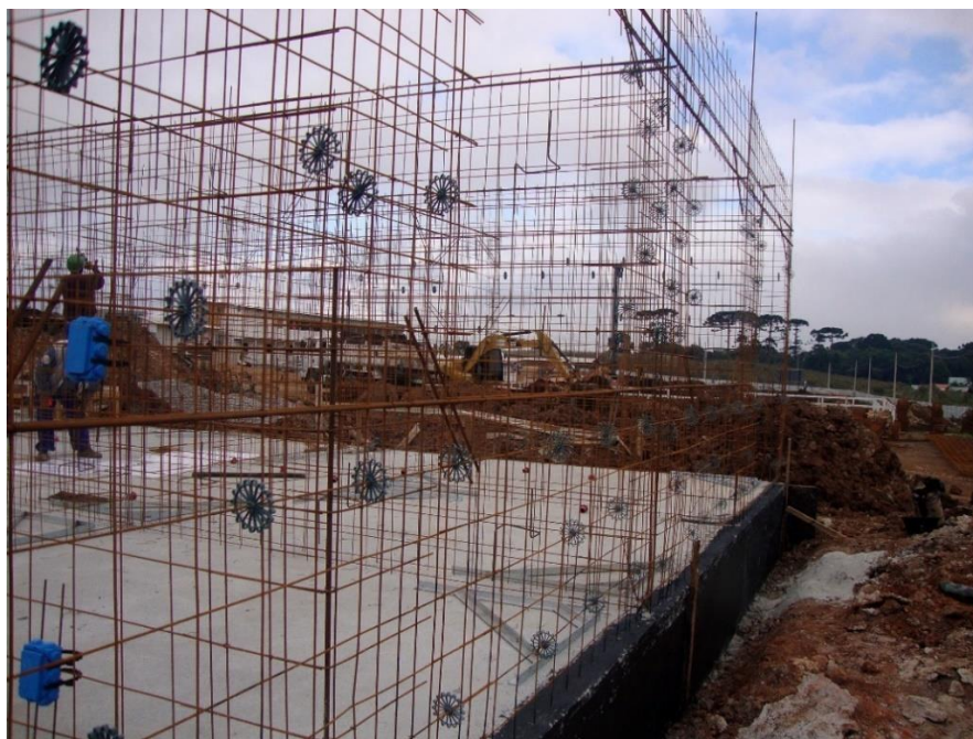
Figura 07: Armação das paredes
