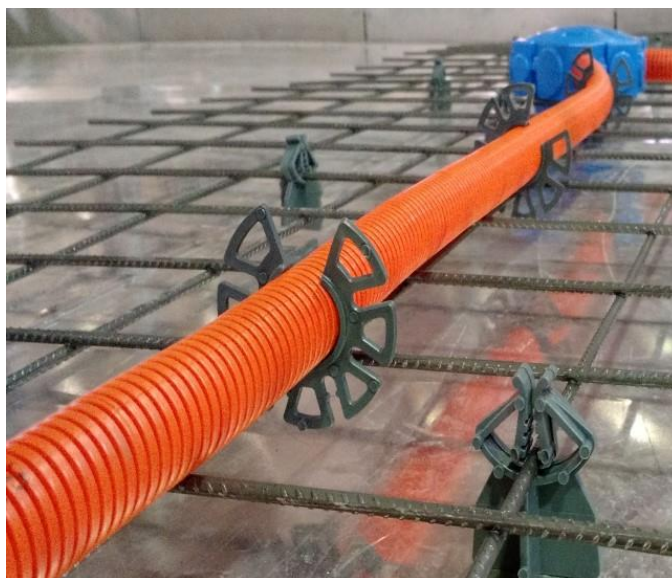
Figura 08: Espaçador circular em eletroduto
