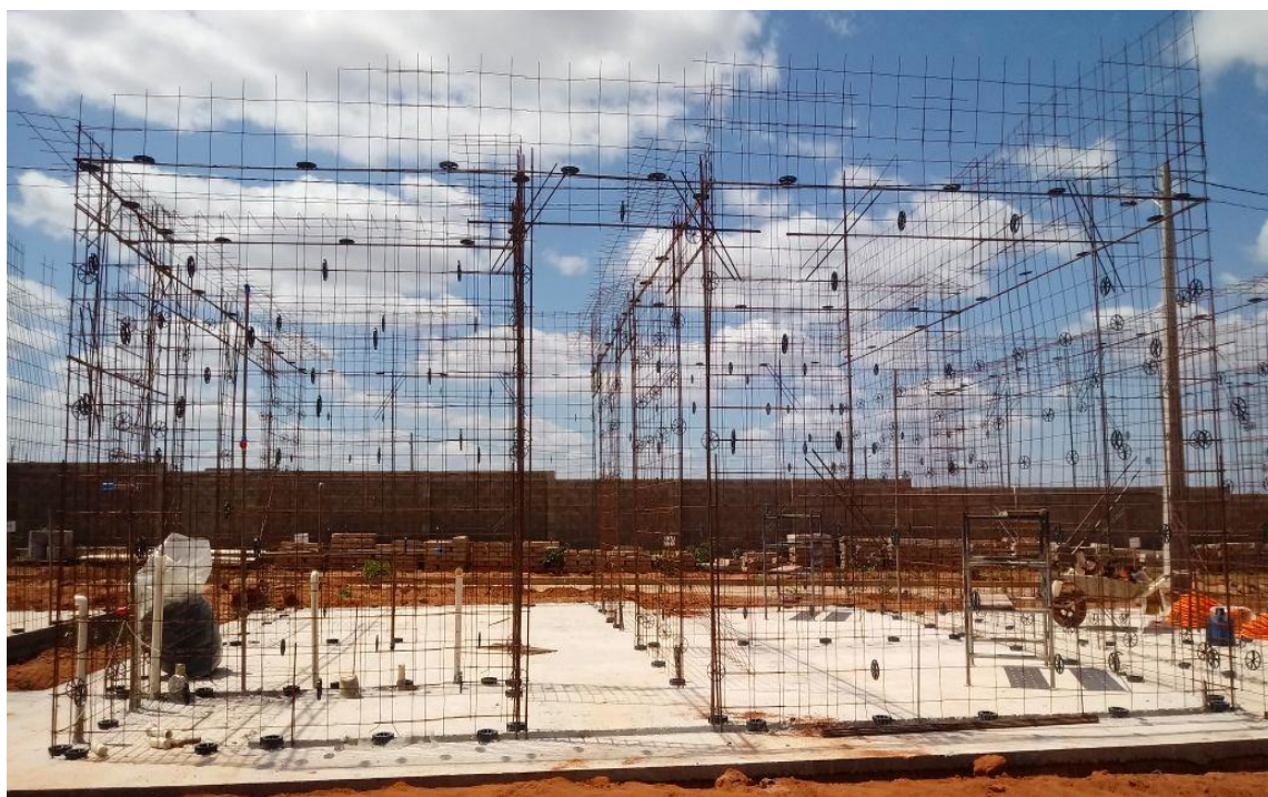
Figura 16: Armação completa das paredes
