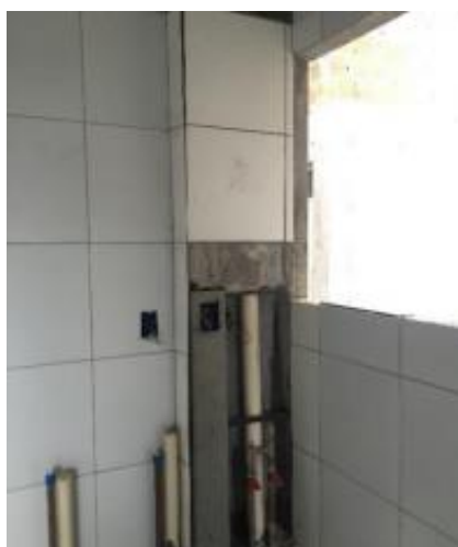
Figura 09: Execução de Shaft
