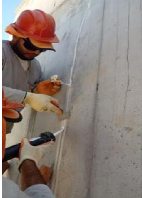
Figura 35: Aplicação do selante
