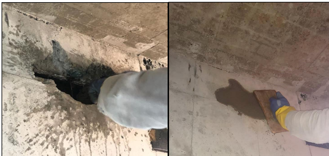
Figura 29: Aplicação do graute e acabamento final
