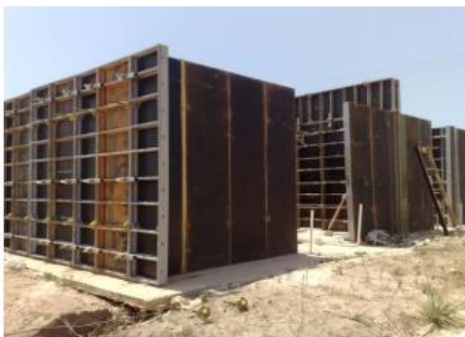
Figura 05: Fôrmas de metálicas para moldagem das paredes de concreto
