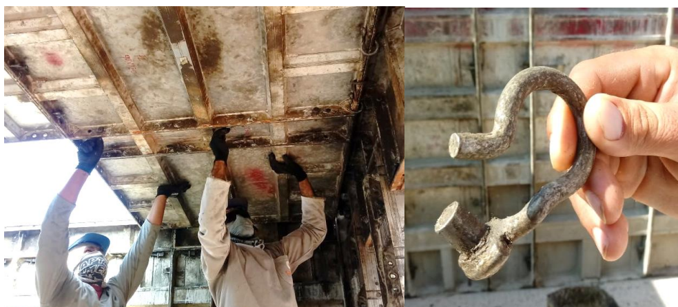
Figura 20: Montagem das fôrmas da laje e chaveta para fixação com as paredes
