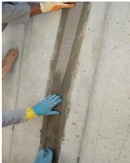
Figura 36: Aplicação da tela com o impermeabilizante
