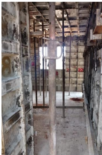
Figura 21: Sistema de escoramento
