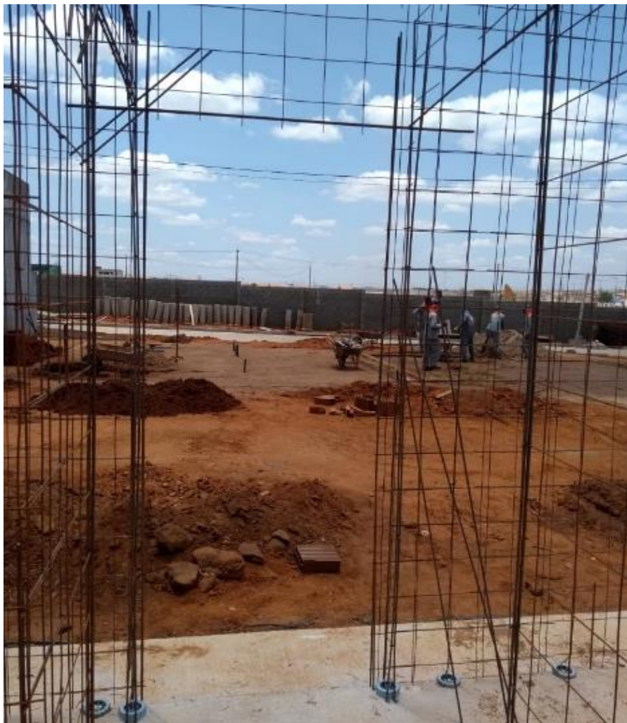
Figura 17: Armadura de reforço com inclinação de 45° para vão de porta
