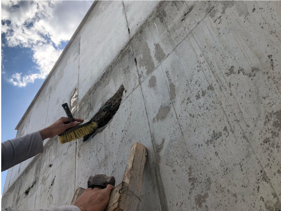
Figura 27: Limpeza para retirada de partículas soltas e umedecimento
