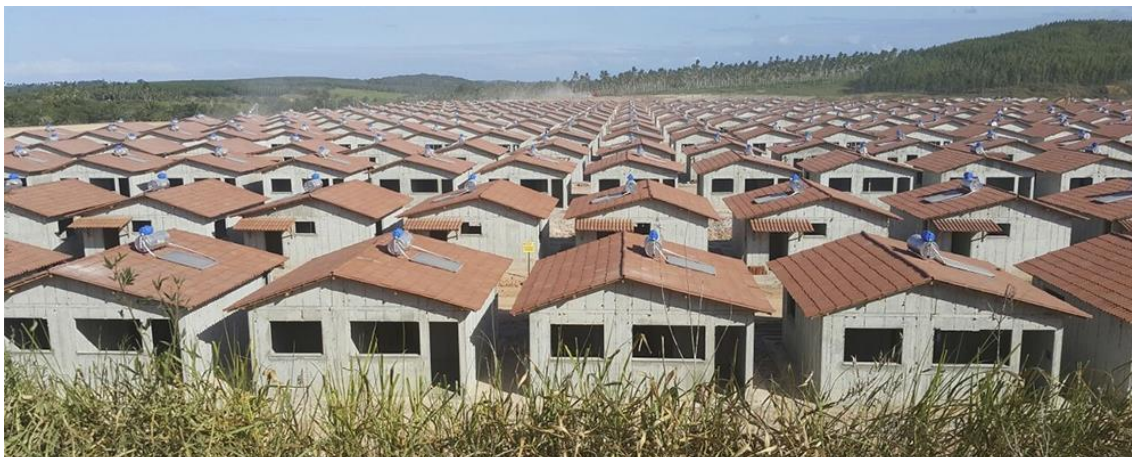
Figura 01: Casas de paredes de concreto moldadas “in loco”.
