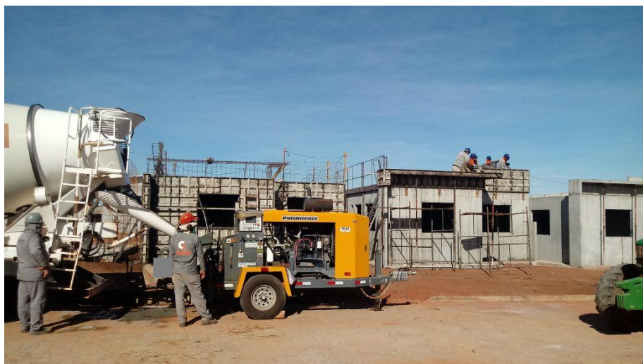
Figura 22: Concretagem de platibanda
