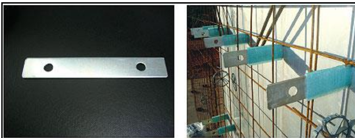
Figura 10: Gravata metálica com camisas plásticas
