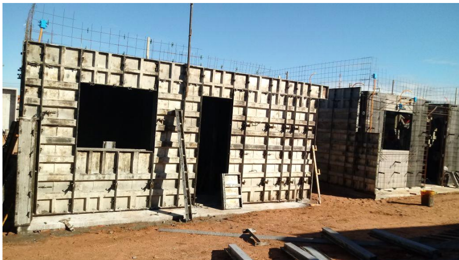
Figura 18: Fôrmas de alumínio utilizadas na obra
