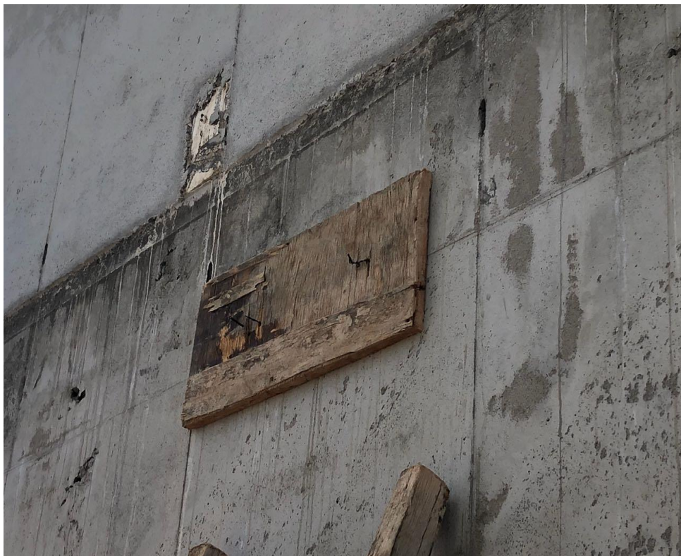
Figura 28: Fixação de fôrma de madeira em uma das faces da parede
