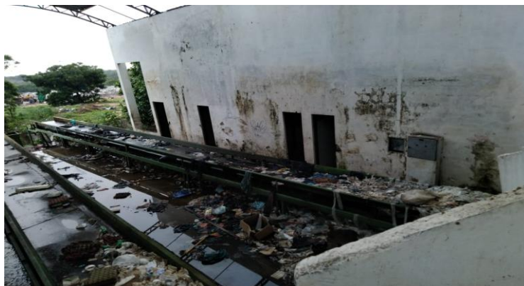
Figura 2 – Condições de usina de triagem inativada
