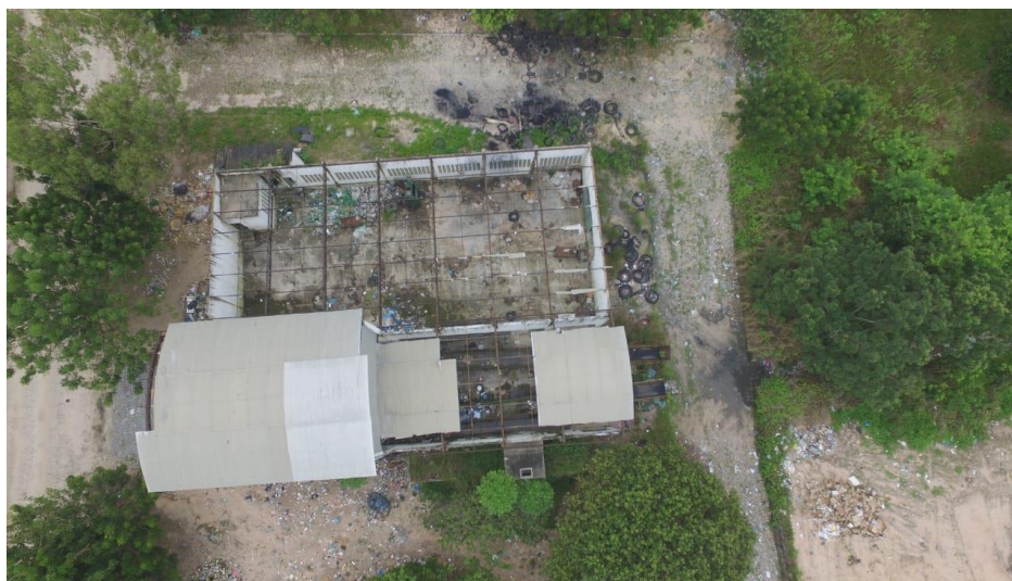
Figura 3 – Vista superior da área da usina de triagem
