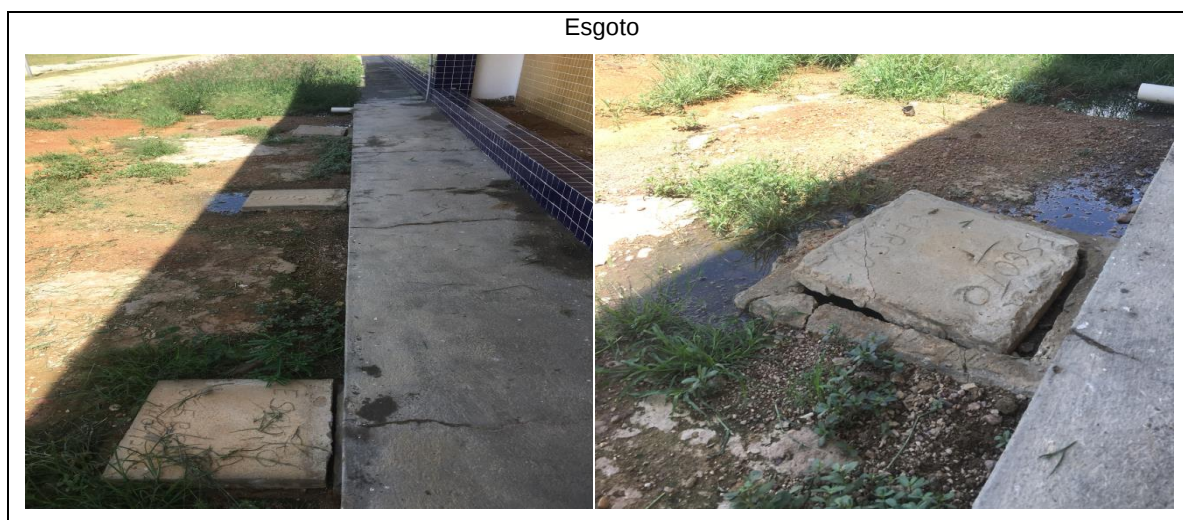
Quadro 1 - Imagens das caixas de inspeção para esgoto do banheiro feminino
