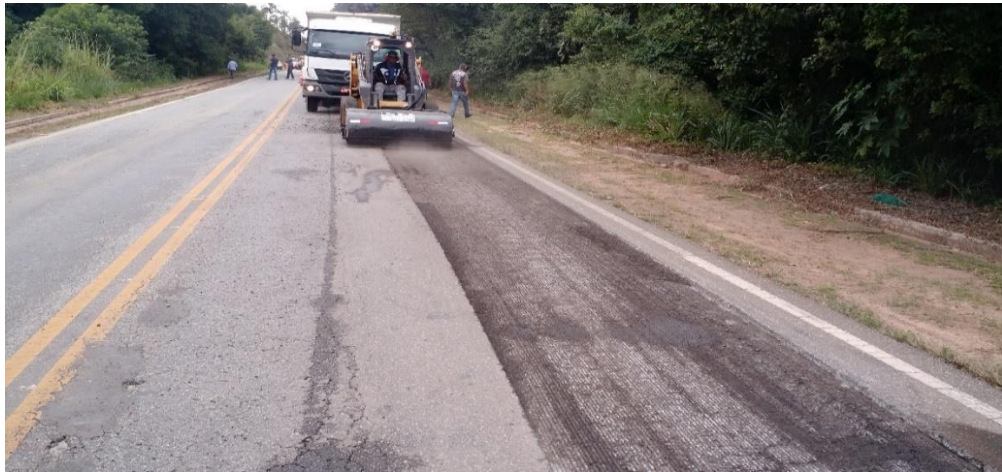
Figura 17: Fresagem
