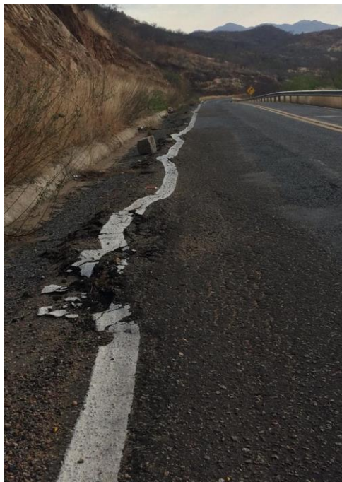
Figura 61: Afundamentos plástico, local 1
