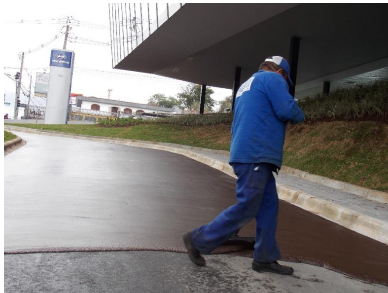
Figura 18: Lama asfáltica
