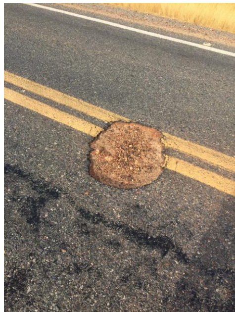
Figura 60: Panelas no eixo da rodovia
