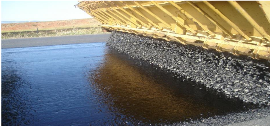
Figura 19: Tratamento superficial duplo
