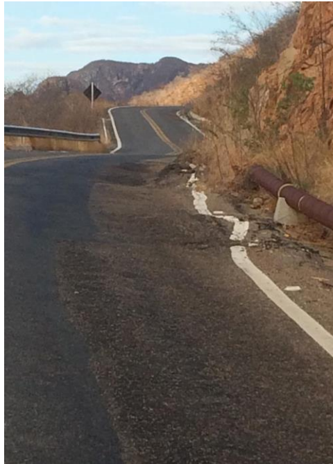
Figura 62: Afundamento plástico, local 2
