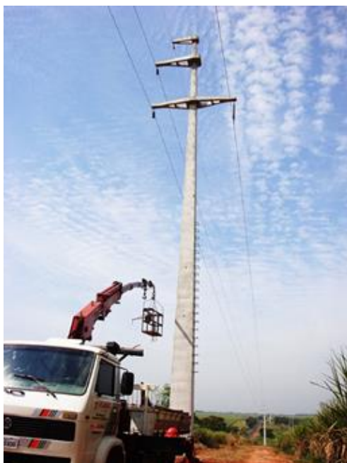
Figura 7 - Estrutura LT tipo poste.
