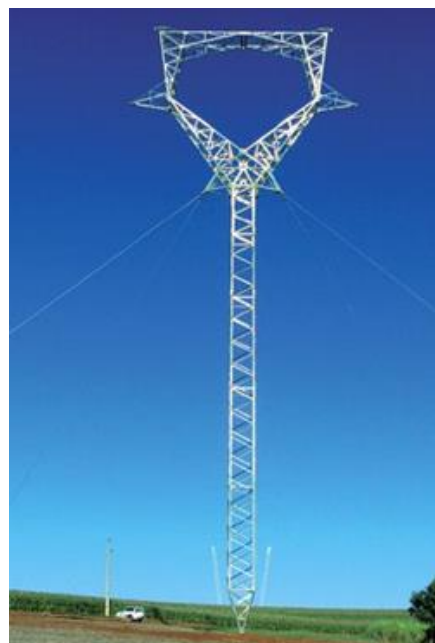
Figura 8 - Estrutura LT treliçada.
