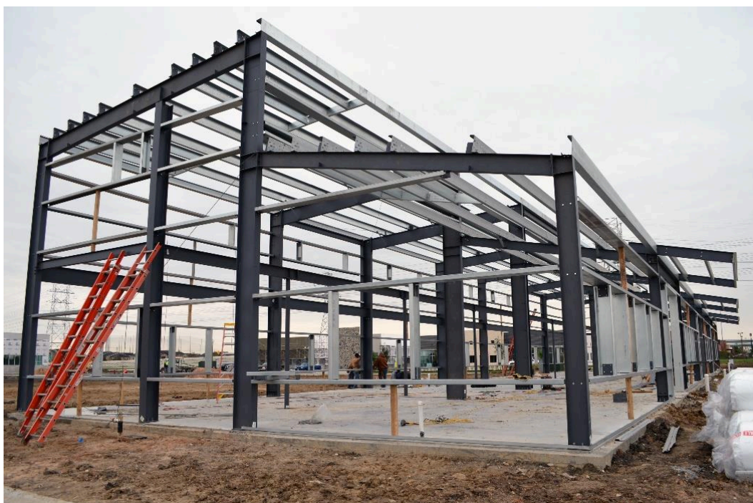
Figura 1 - Estrutura em elementos de aço.
