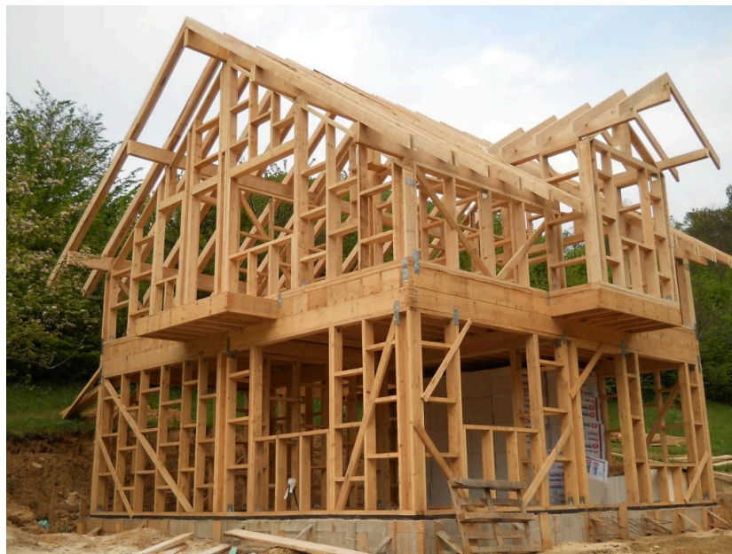
Figura 2.1 – Residência feita em Wood Frame
