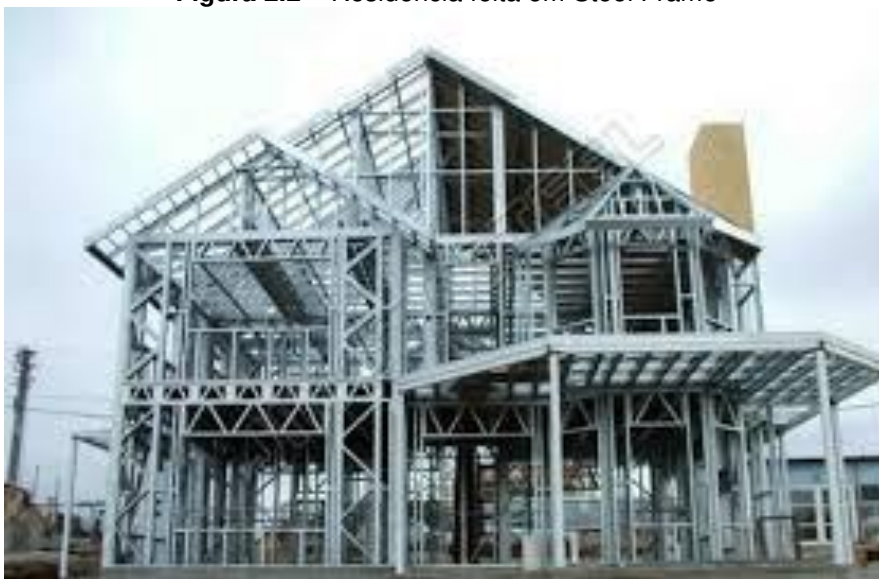
Figura 2.2 – Residência feita em Steel Frame
