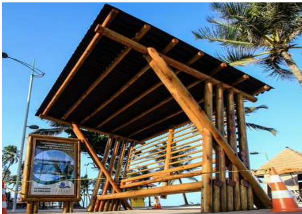
Figura 1 - Abrigo de ônibus na cidade de Maceió – AL (MADEIRA)
