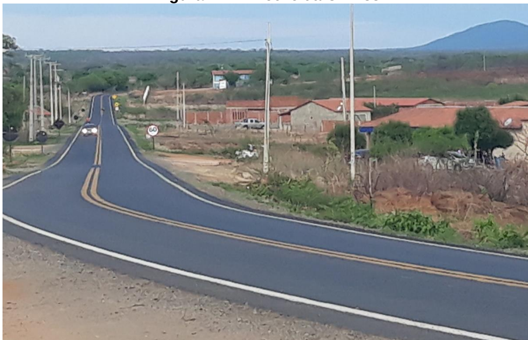
Figura 17 Trecho da CE-138
