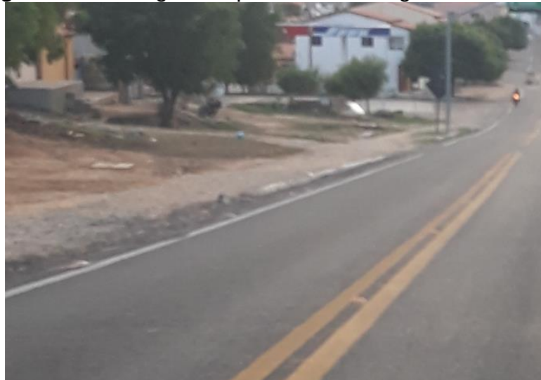
Figura 22: Passagem de pedestres a margem da CE-138
