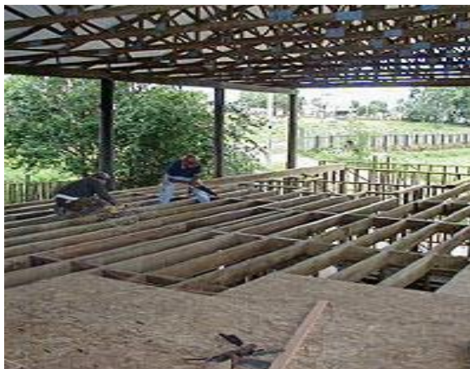
Figura 11 – Barroteamento de piso e contrapiso de OSB
