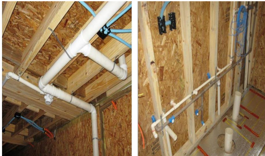
Figura 13 - Instalação elétrica e hidráulica embutida na parede
