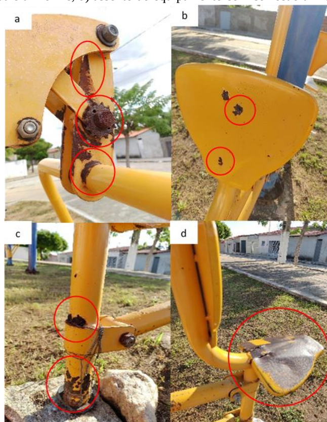
Figura 38: Aparelho puxador peitoral duplo, a) região superior do lado direito de rotação do equipamento com corrosão uniforme, galvaniza e em torno do cordão de solda, b) região frontal de acostamento do assento com corrosão alveolar e uniforme, c) região inferior frontal da base do assento com corrosão em torno do cordão de solda e uniforme, d) assento do equipamento com corrosão uniforme.
