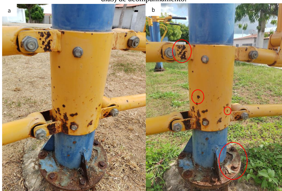
Figura 39: a) base de apoio estrutural do aparelho puxador peitoral duplo nos primeiros três meses (90 dias) de acompanhamento, b) base de apoio estrutural do aparelho puxador peitoral duplo nos últimos três meses (90 dias) de acompanhamento.
